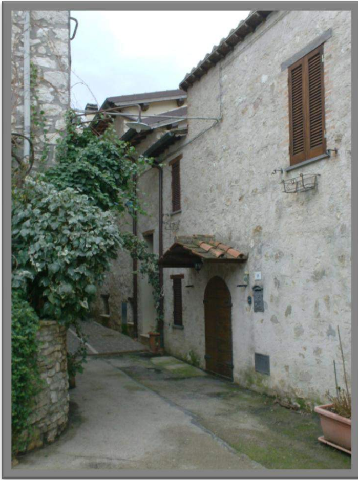
Vicolo da cui sono raggiungibili il Sub. 9 e il Sub. 11
