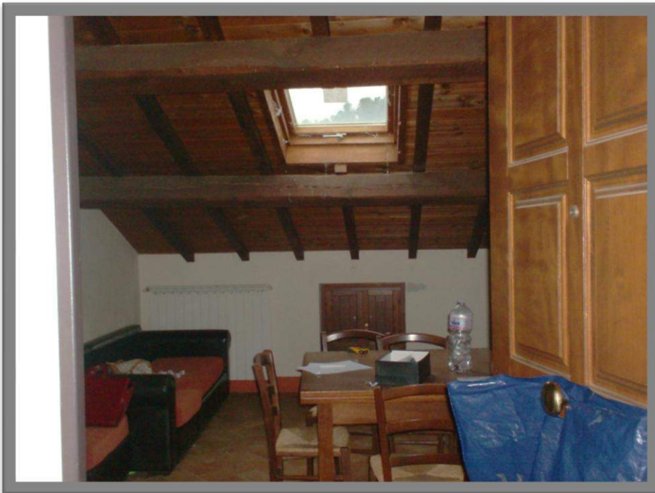
Sub. 9 -Vista della zona Soggiorno/Pranzo
