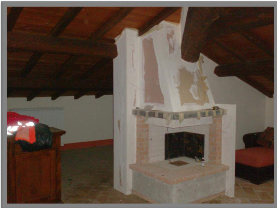
Sub. 11 -Vista della zona Soggiorno/Pranzo
