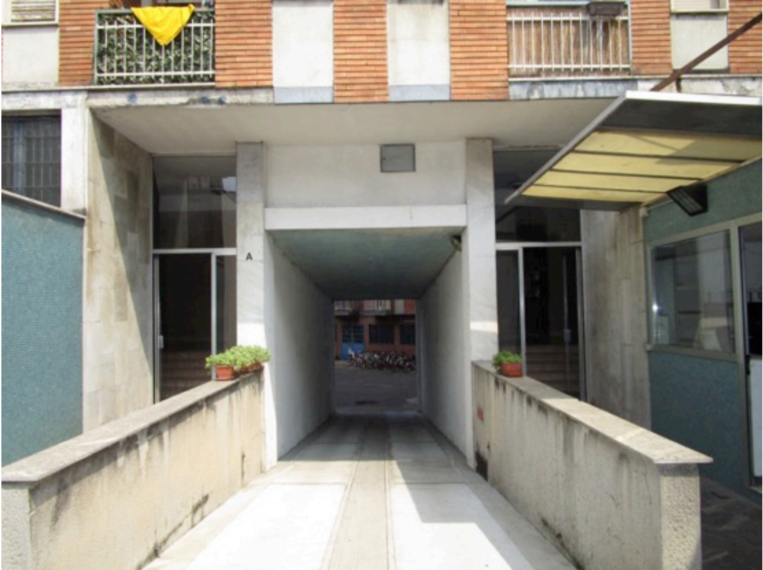
5. Rampa per accesso carraio e portineria sulla destra.
