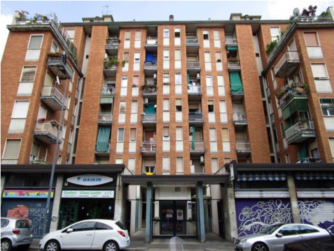
1. Fabbricato fronte strada di Via Ambrogio Binda 33.
