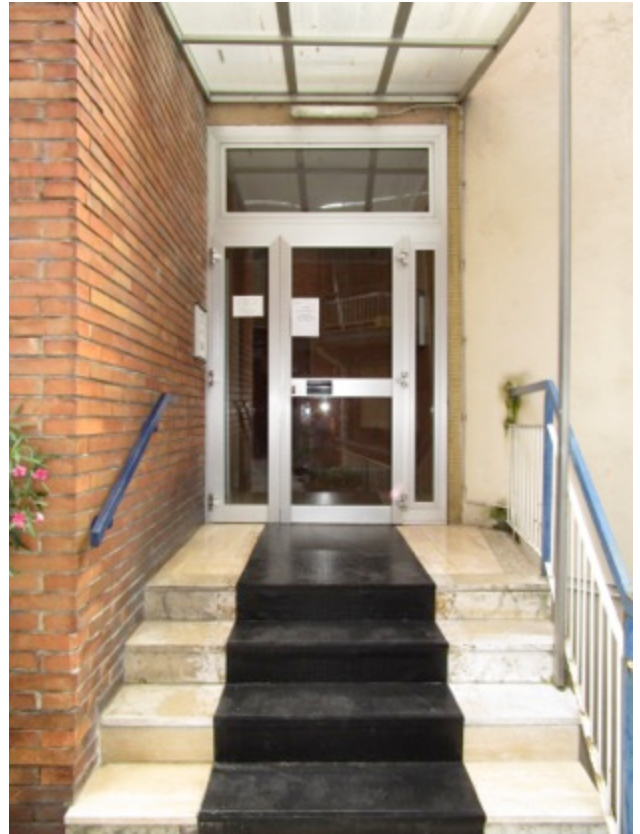
10. Scale di accesso all'androne del fabbricato interno.
