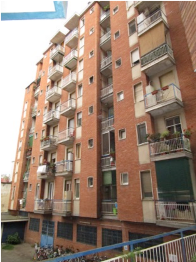
9. Fabbricato sul retro prospiciente il cortile interno.
