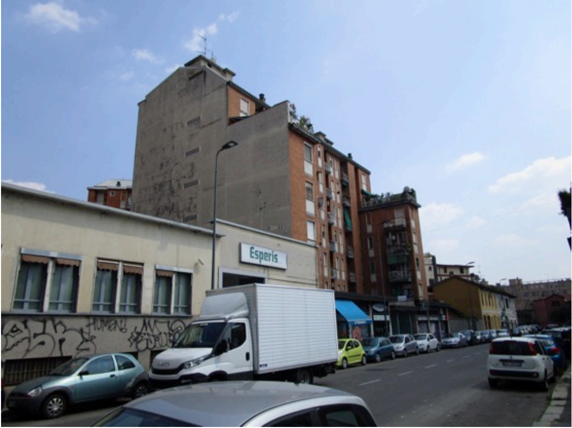
3. Fabbricato di via Via Ambrogio Binda lato nord.
