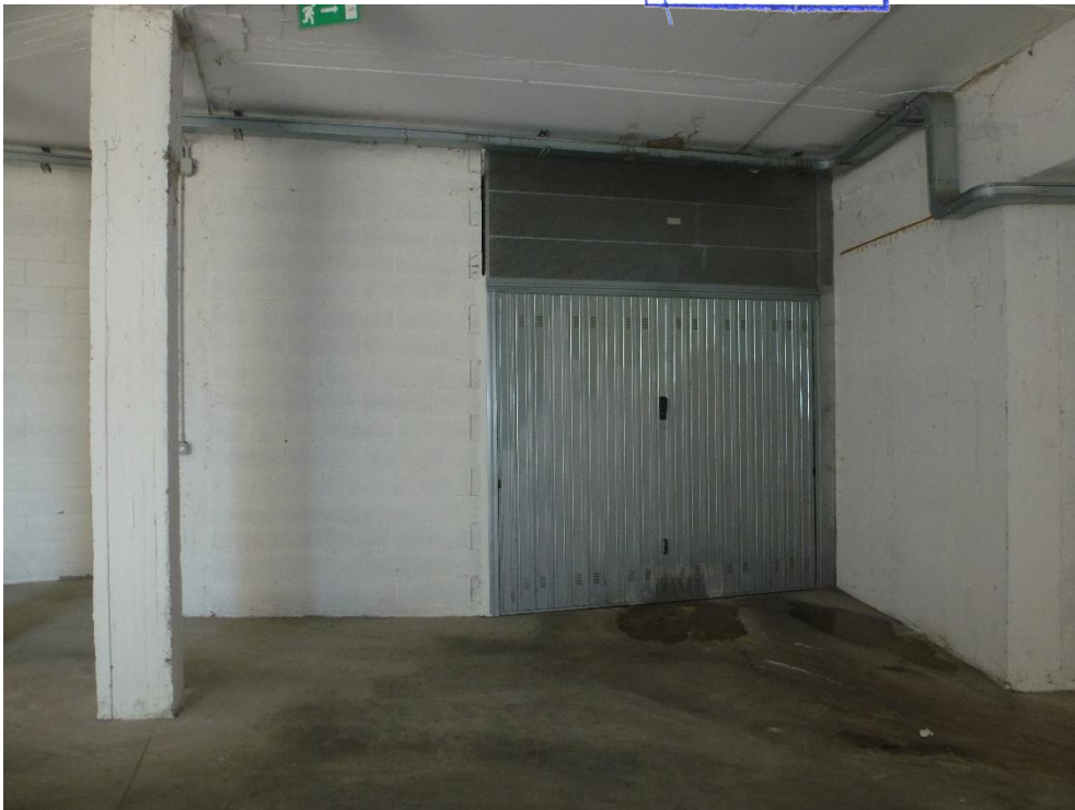
Foto n.28 – sub.40 ingresso garage piano primo sottostrada
