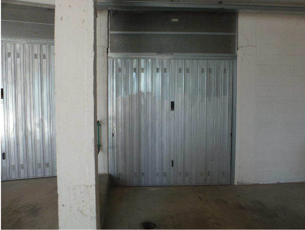
Foto n.11 ingresso garage sub.39
