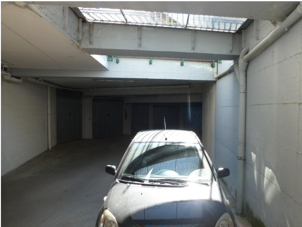
Foto n.06 – parti comuni sub.61
