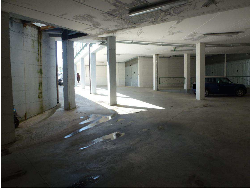
Foto n.07 – parti comuni sub.61
