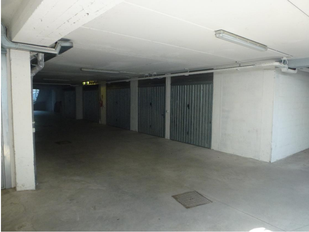
Foto n.05 – parti comuni sub.61
