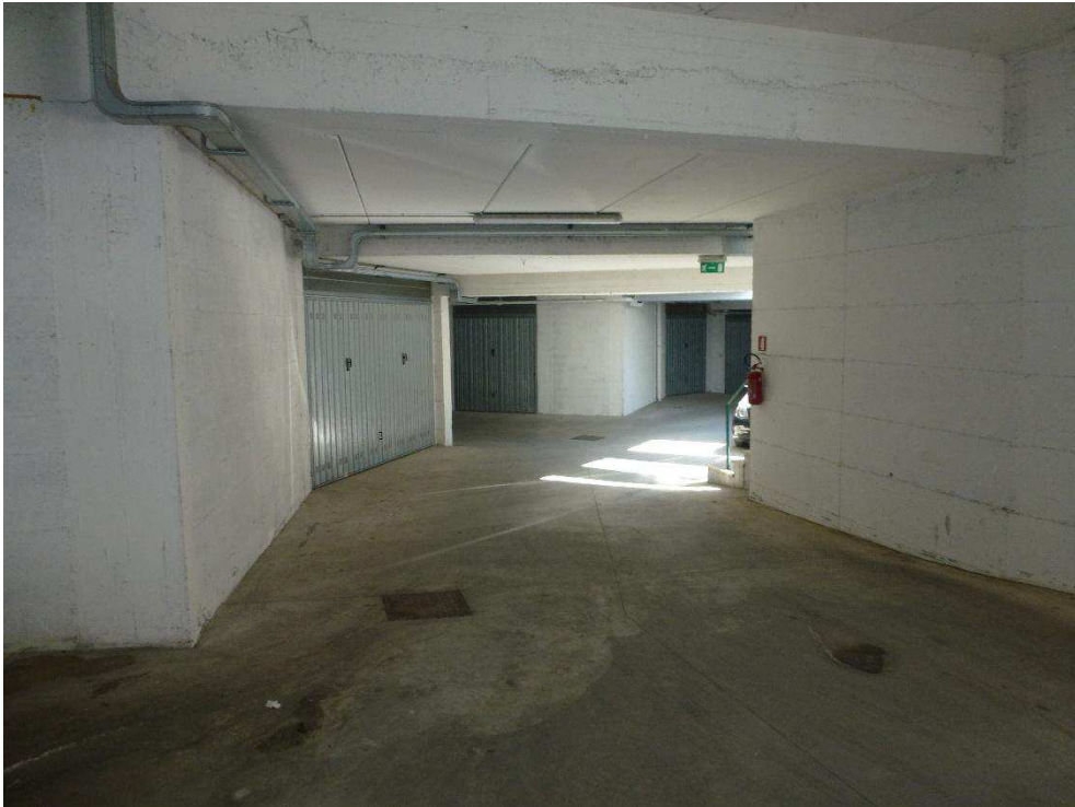
Foto n.08 – parti comuni sub.61
