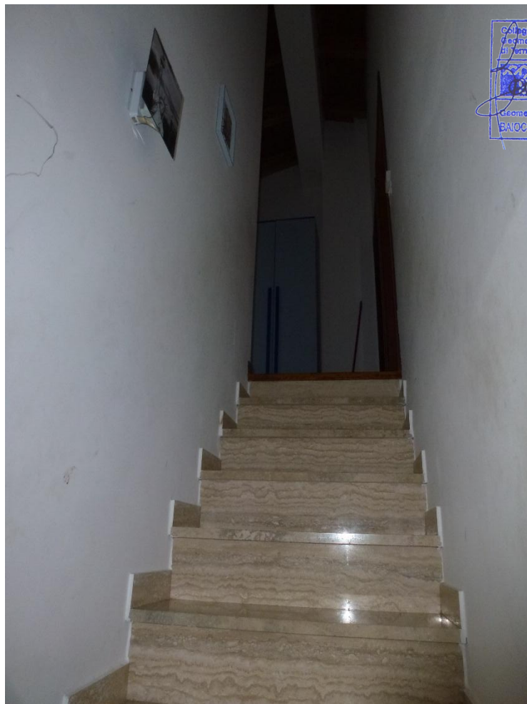
Foto n.12 – scala di collegamento piano terra/primo
