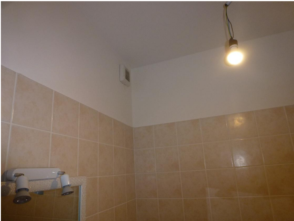
Foto n.10 – bagno piano terra
