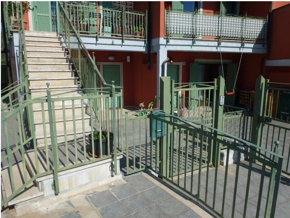
Foto n.02 – parti comuni sub.61
