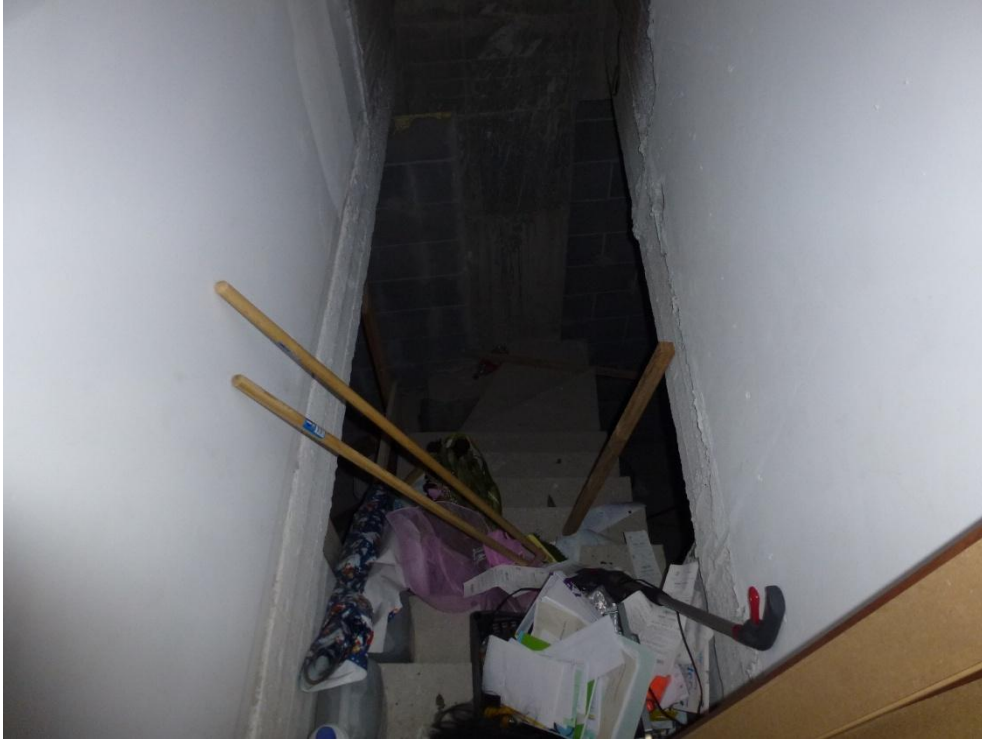
Foto n.19 – scala di collegamento con piano primo sottostrada
