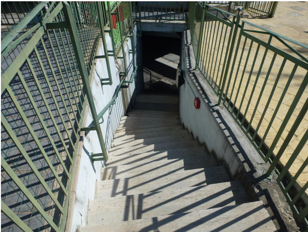
Foto n.04 – parti comuni sub.61
