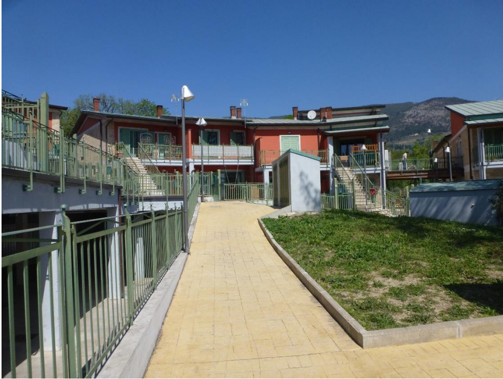
Foto n.09 – parti comuni sub.61
