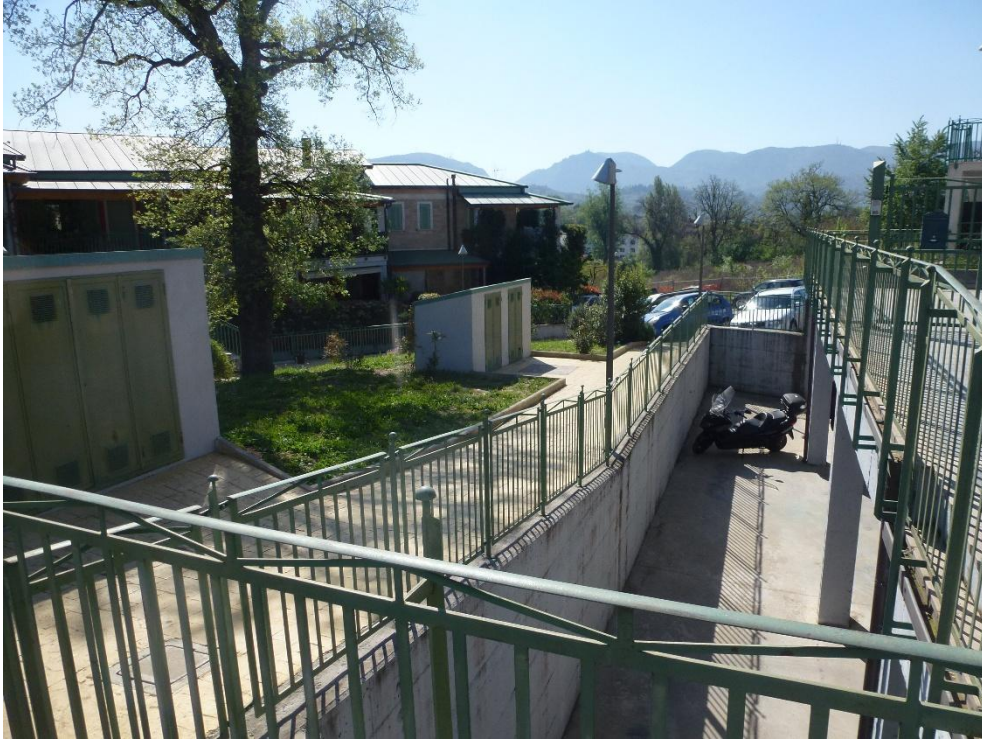
Foto n.03 – parti comuni sub.61
