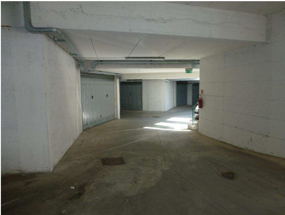
Foto n.08 – parti comuni sub.61
