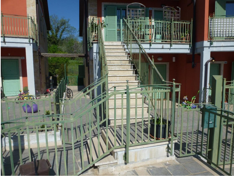
Foto n.01 – parti comuni sub.61
