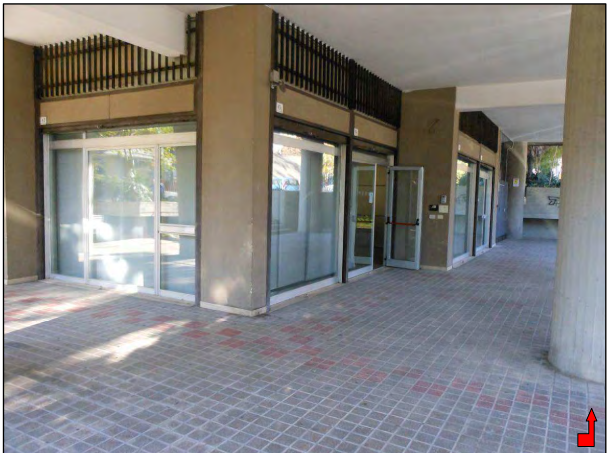
(UFFICIO, vista esterna -
