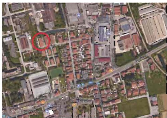
Vista aerea generale
