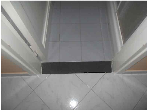
Particolare pavimentazione Disimpegno/Bagno
