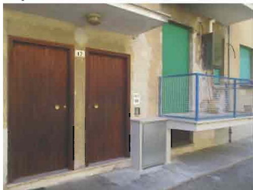
Ingresso al condominio
