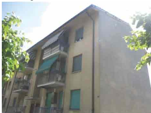
Prospetto - lato anteriore
