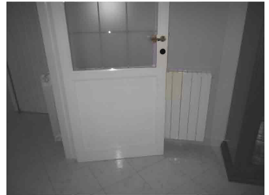
Particolare infisso interno
