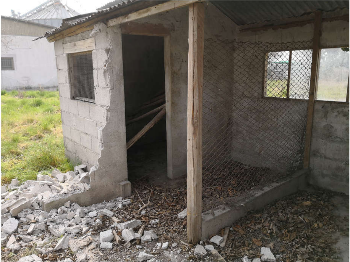
53 - deposito esterno 2 interni
