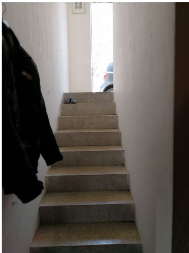
25 - scala cantina ingresso secondario
