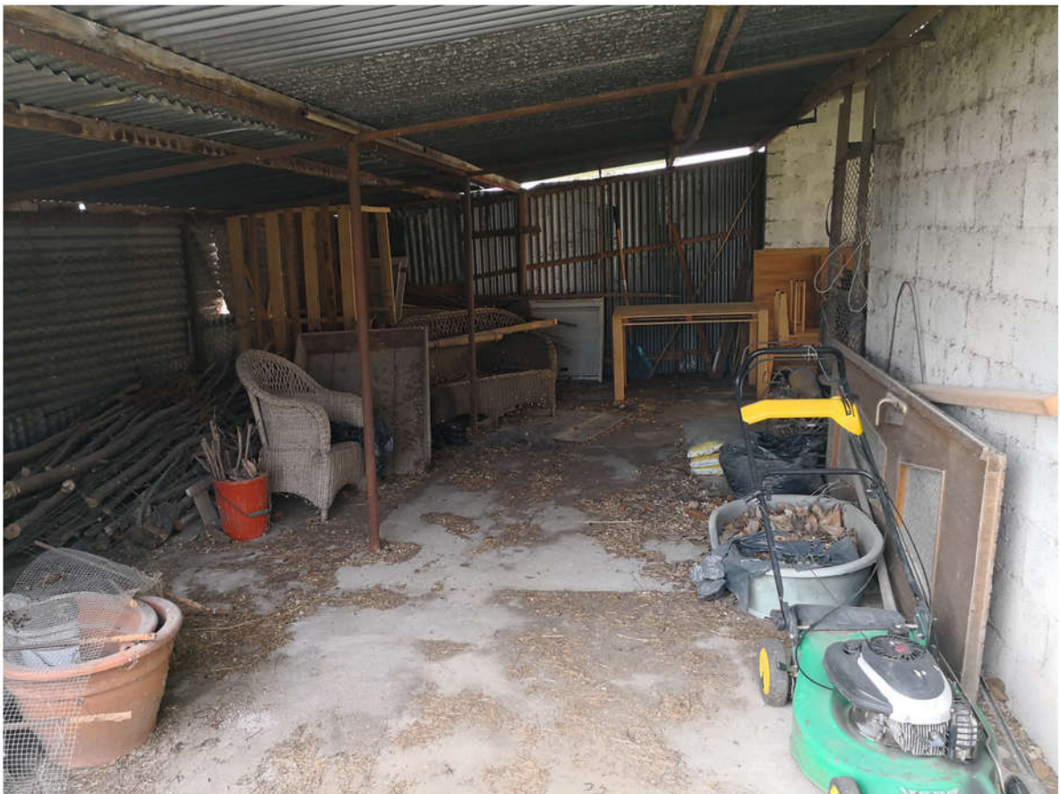
46 - deposito esterno interni
