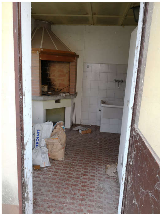
49 - deposito esterno lavanderia doccia
