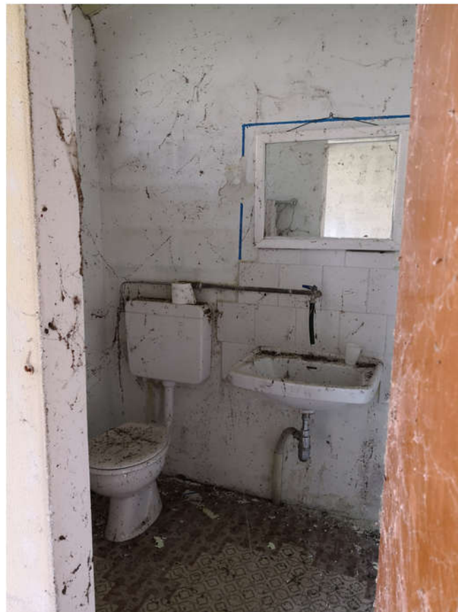
48 - deposito esterno wc
