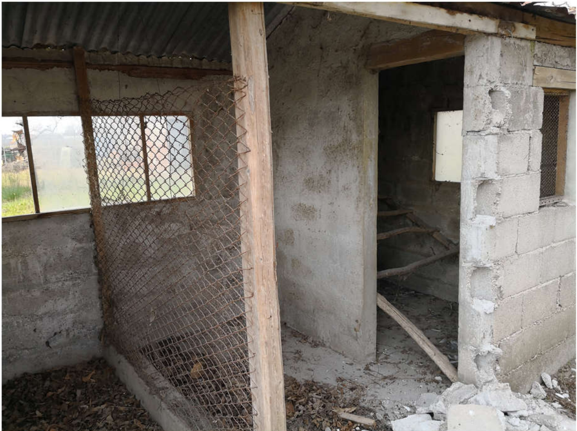
54 - deposito esterno 2 interni
