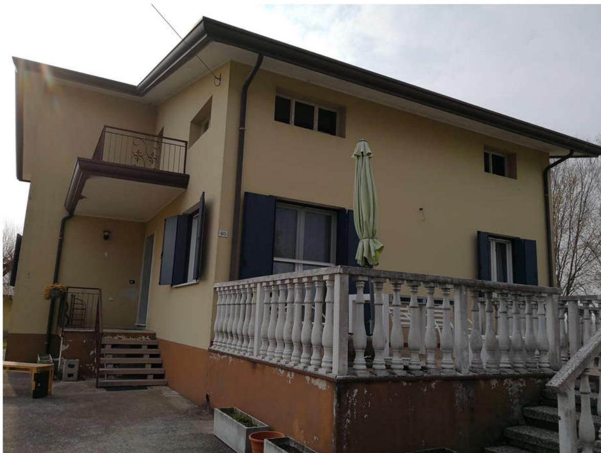
1 - fronte abitazione est
