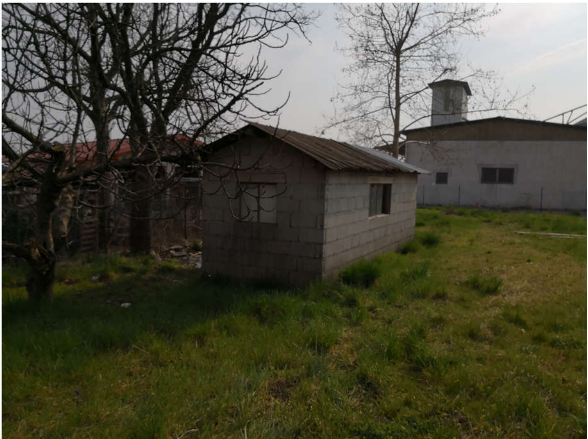
52 - deposito esterno 2 fronte
