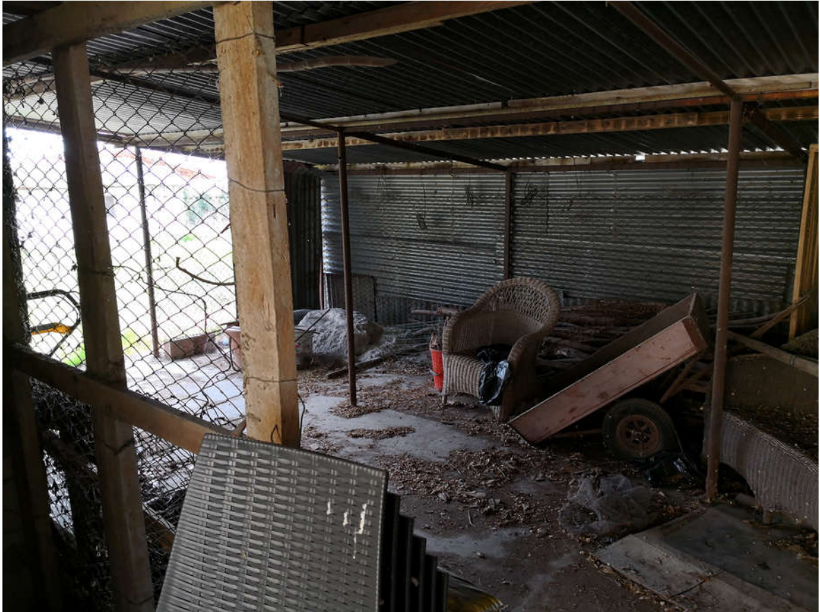
47 - deposito esterno interni
