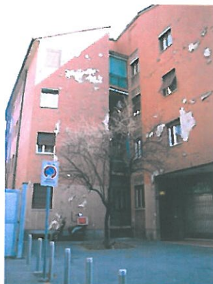
Facciata civico N.47
