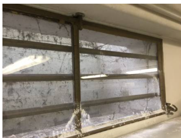
Fig.32: particolare finestra e bocca di lupo.
