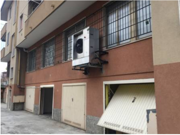
Fig.7-8: viste dell'edificio dal corso di manovra.
