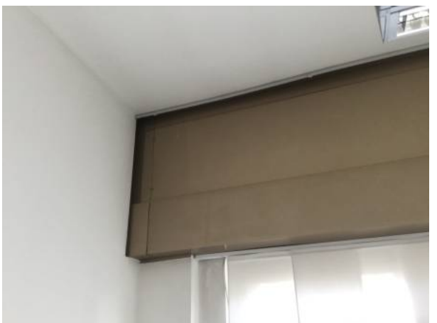
Fig. 24: particolare cassonetto metallico.
