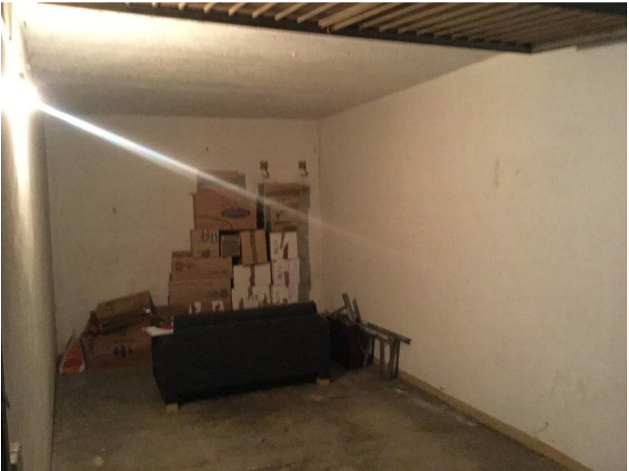
Fig.37: particolare interno autorimessa.
