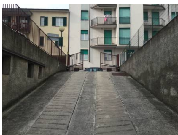
Fig.34: vista della rampa dal corsello.
