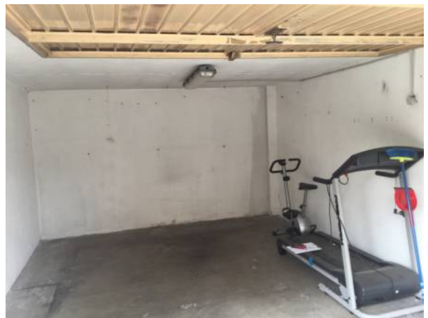
Fig.10: vista del box.
