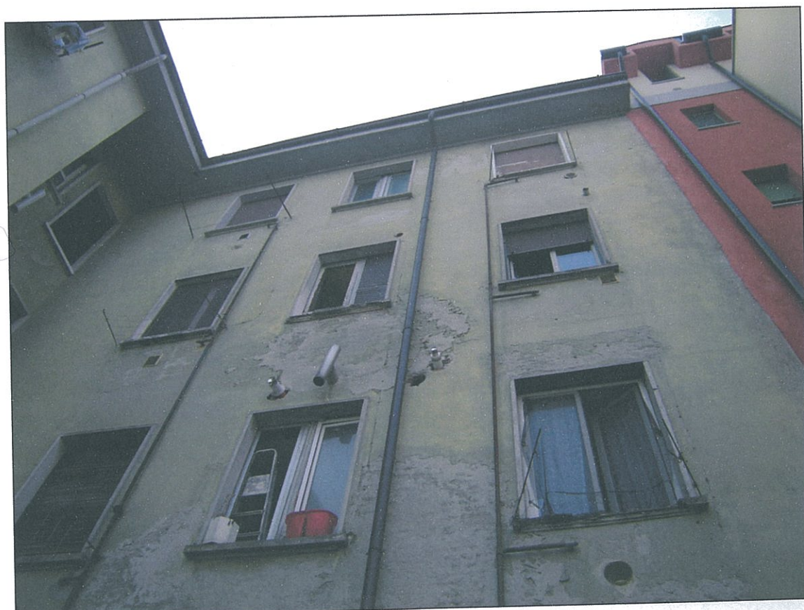
Foto 10 – La facciata interna.
