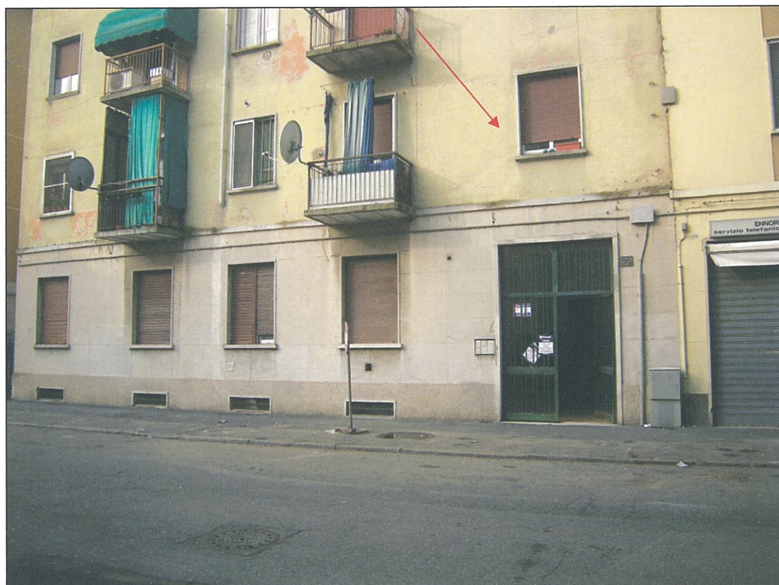
Foto 2 - L'unità in esame al piano primo.
