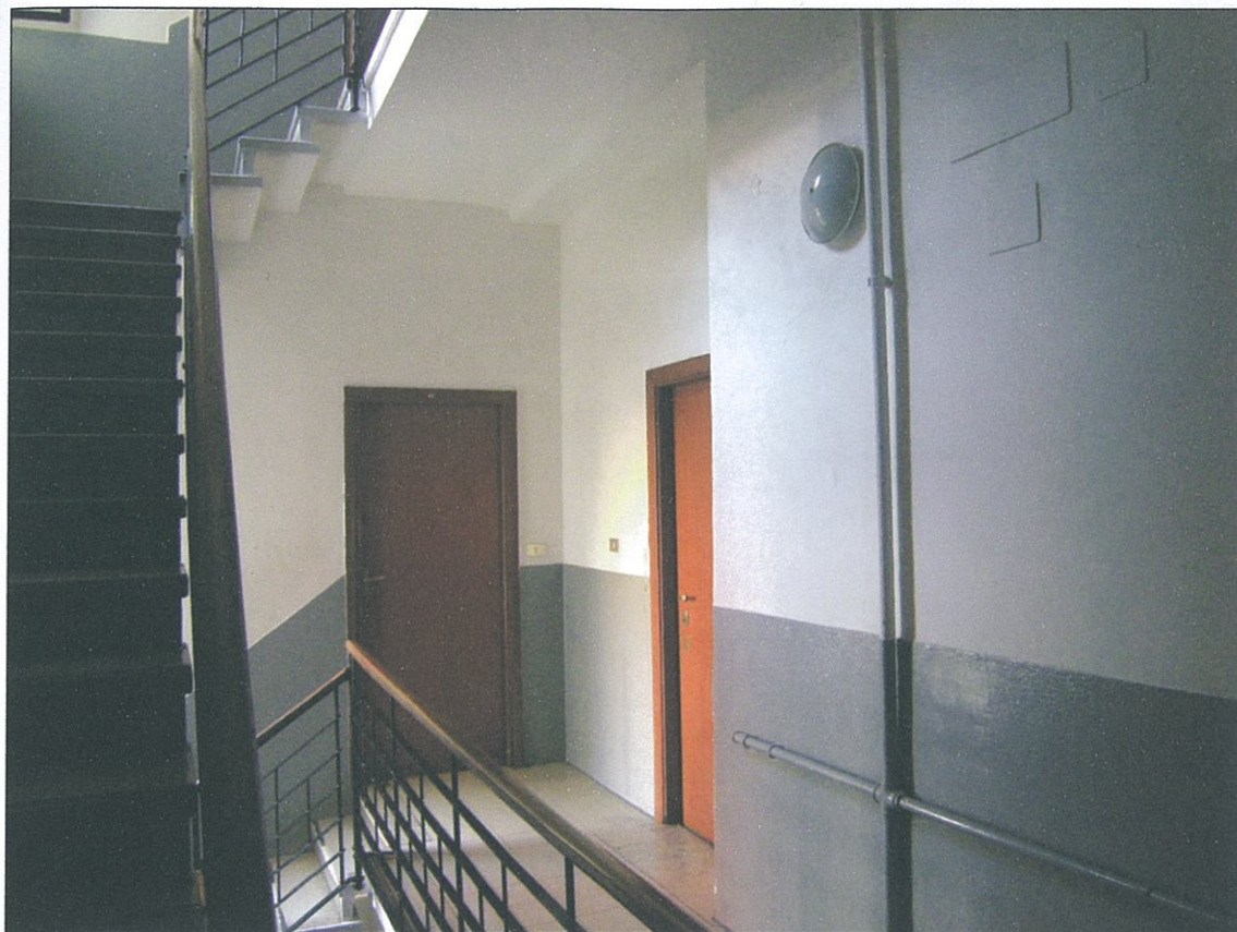
Foto 7 – Il pianerottolo del primo piano.
