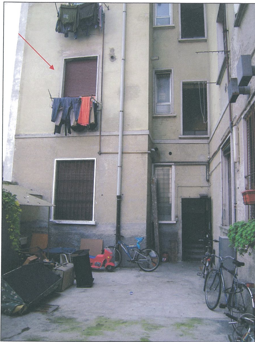
Foto 11 – La facciata interna con la finestra dell'unità in esame.
