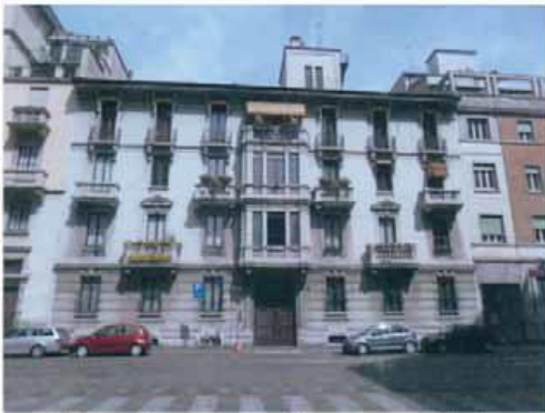
Vista esterna immobile condominiale
