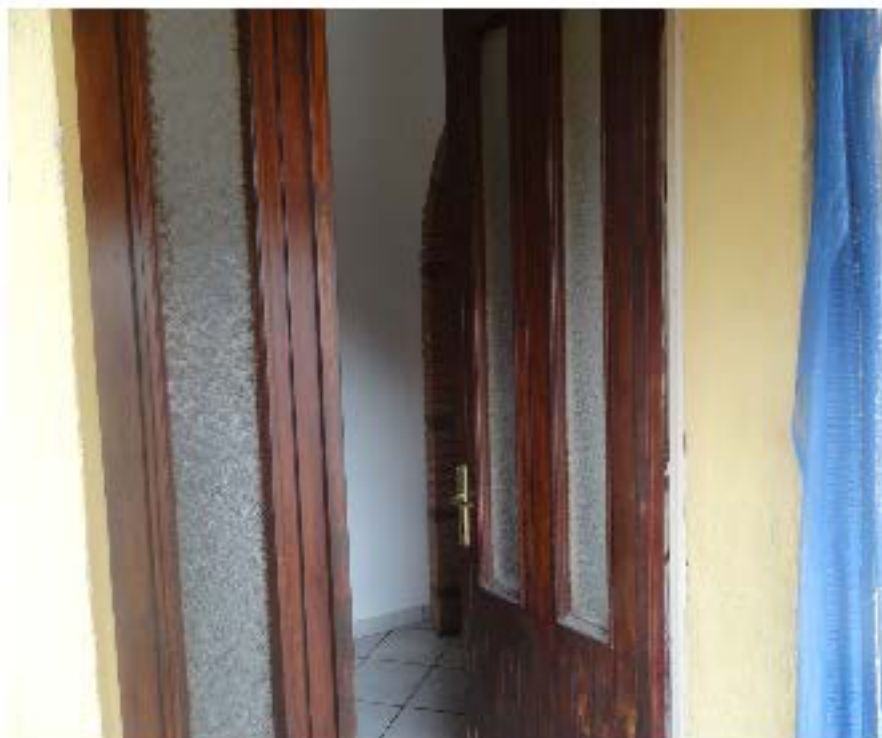
Foto esterna – dettaglio serramento esterno per accesso balcone
