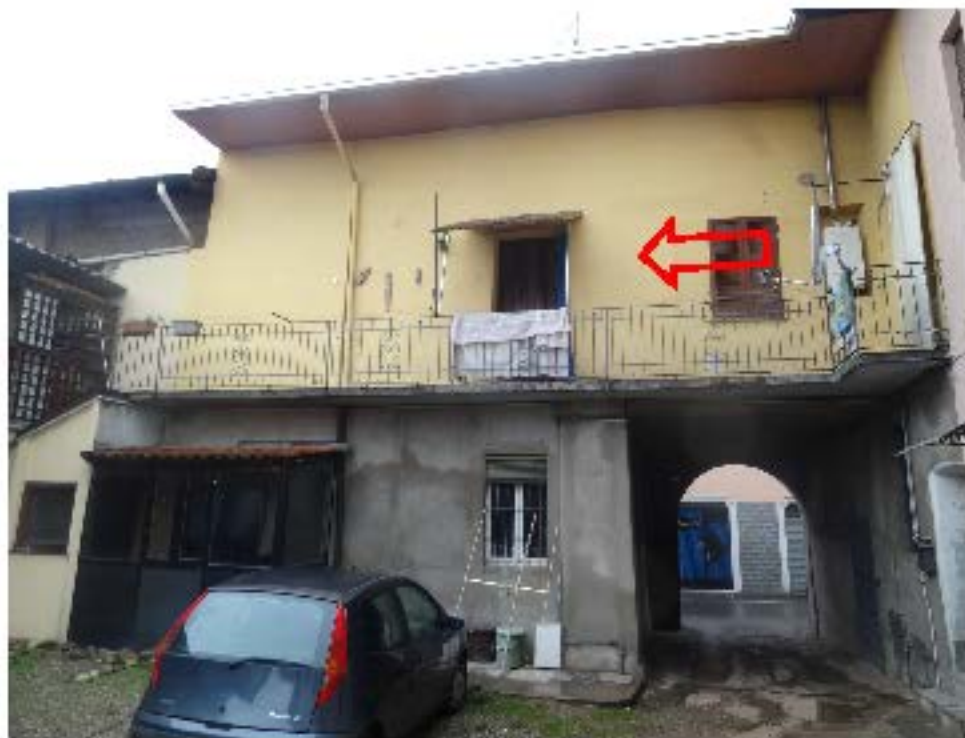
Foto esterna - corte interna con cespite di riferimento
