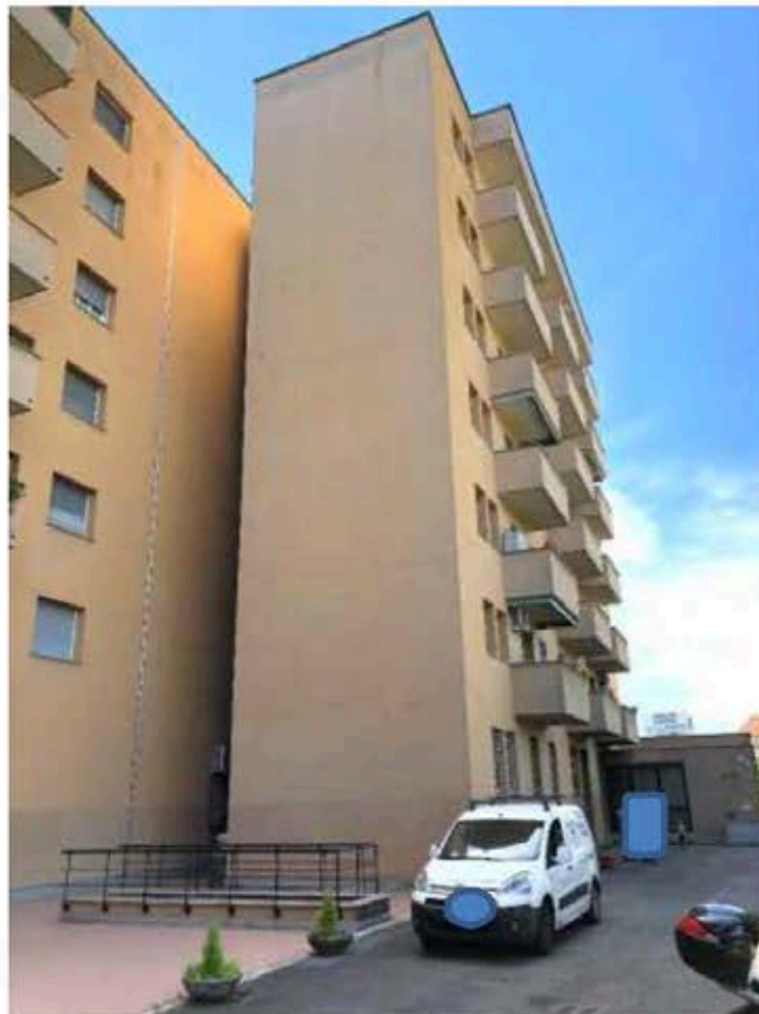
Vista cortile interno con vano scala di accesso alle cantine
