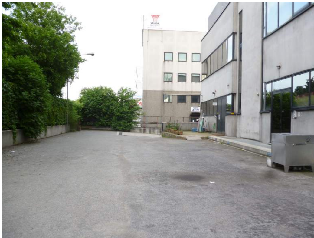
FOTO 16 – Retro edificio con area posti auto scoperti ed imbocco rampa al piano interrato
