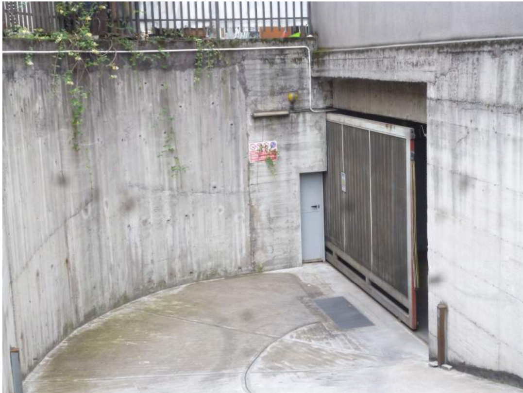
FOTO 13 – Rampa accesso ai box piano interrato
