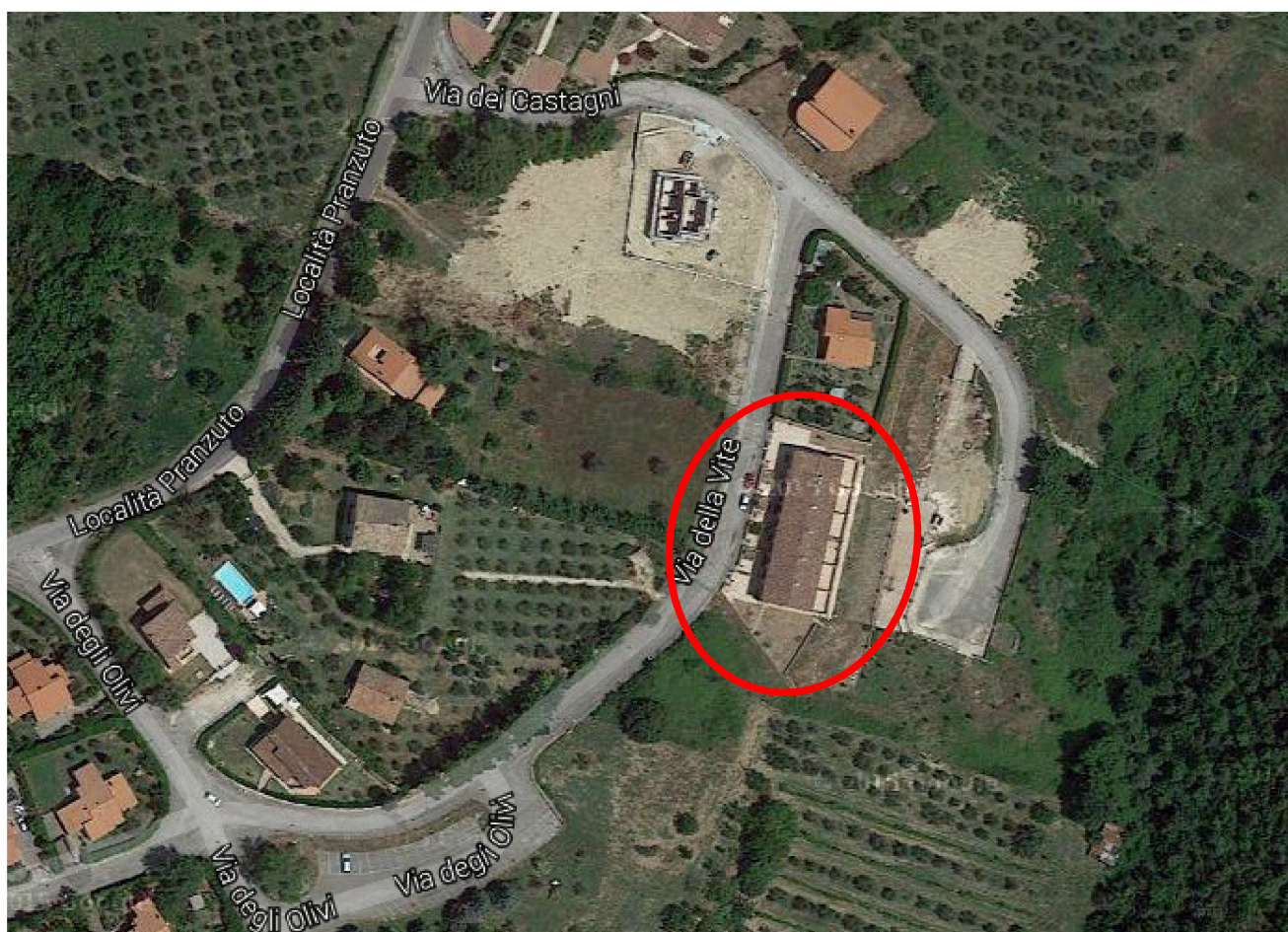
Foto n. 1. – Foto aerea dell'edificio contenente il lotto 1 e il lotto 2.
