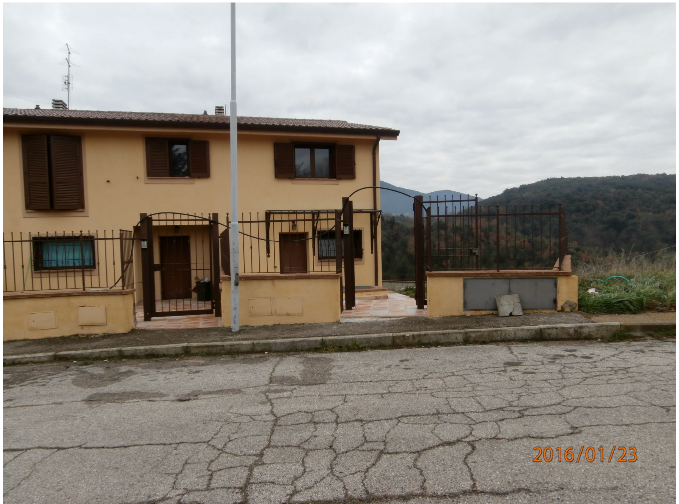
Foto n. 5. – LOTTO 1 – Ingresso pedonale da Via della Vite del Sub 6 e del Sub 12.
