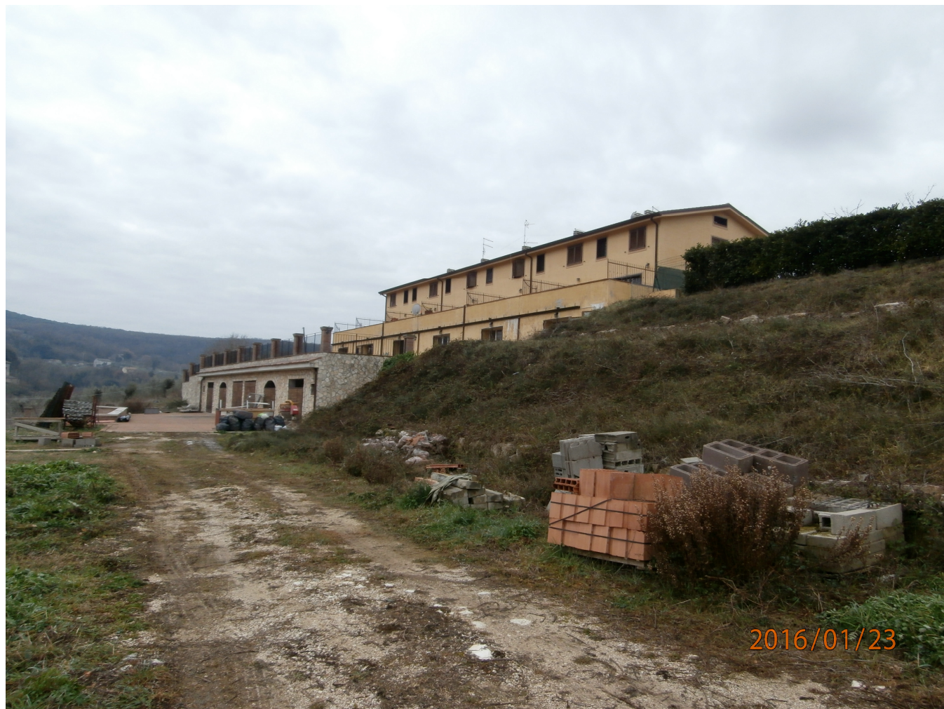
Foto n. 3. – Ripresa fotografica dalla rampa di accesso agli autoveicoli che porta alle autorimesse: queste ultime si trovano in altra particella catastale non rientrante nel compendio pignorato. (Si noti in basso, la terrazza -giardino sistemata “a verde” che costituisce la copertura delle autorimesse).
