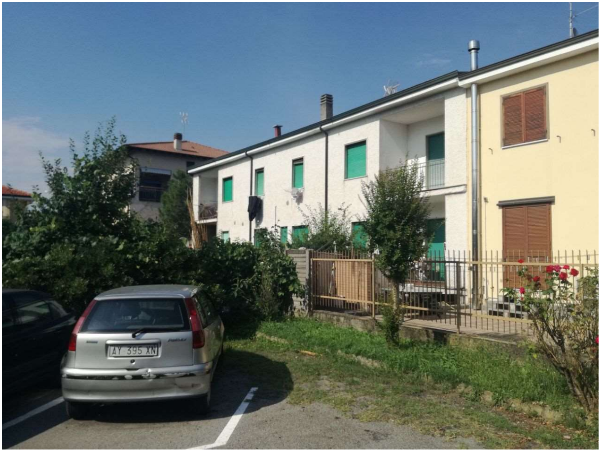
Vista dell'immobile dall'esterno, lato cortile interno
