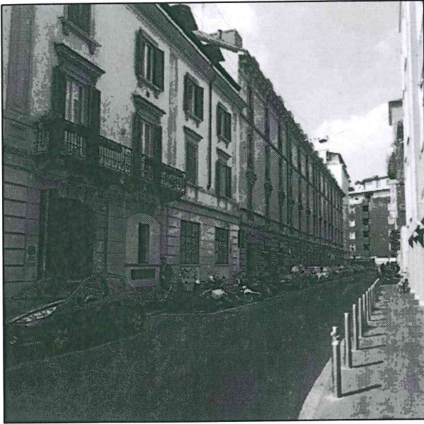
Fig. 5: Edificio visto dall'esterno.
