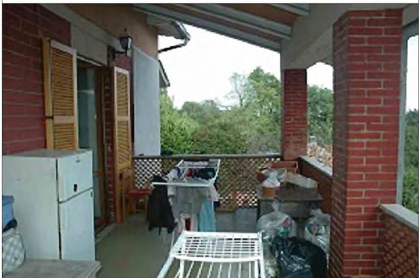
Foto 28) piano primo - terrazzo
