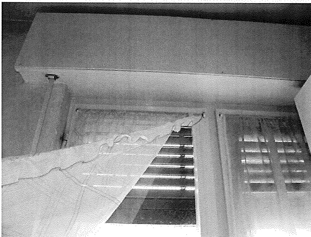
Cucina – Particolare serramenti
