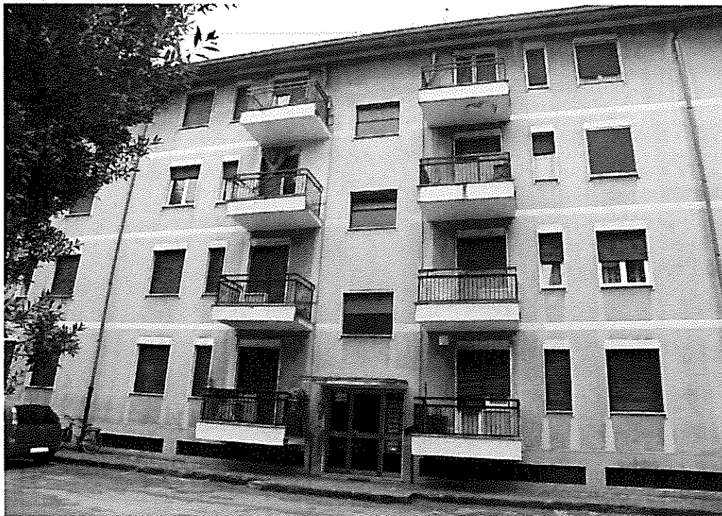
Vista esterna dello stabile – foto 2
