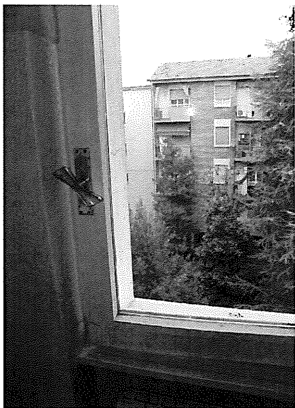
Bagno – Particolare serramenti
