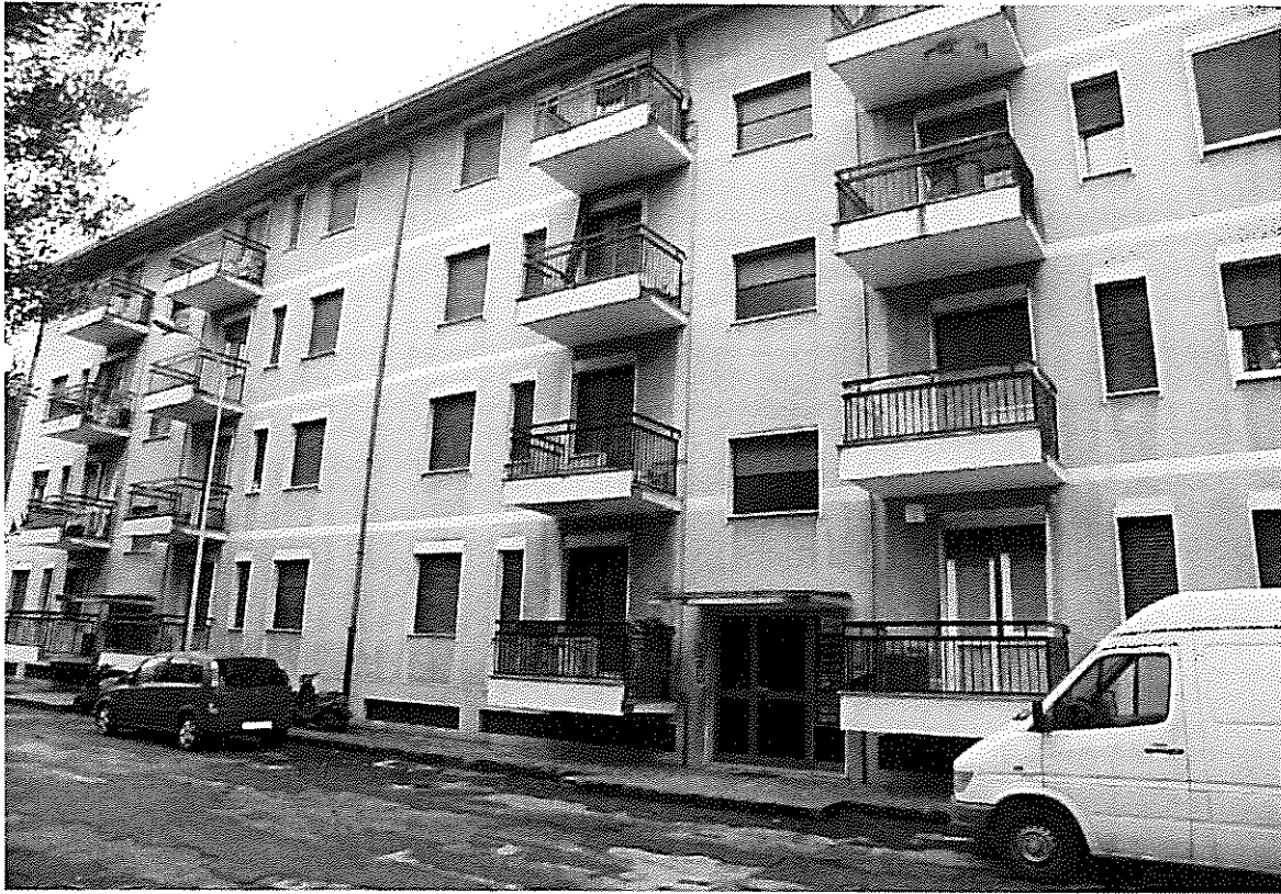
Vista esterna dello stabile – foto 1
