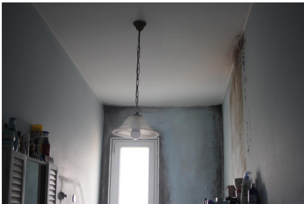
FOTO 10: MILANO, VIA DEI SALICI 6, bagno
