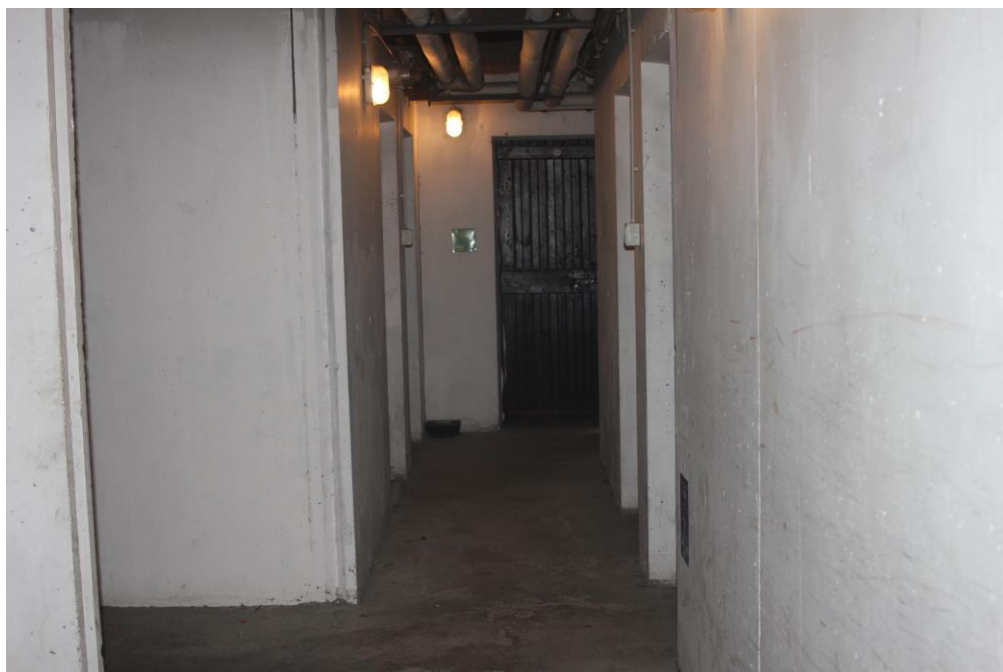
FOTO 11: MILANO, VIA DEI SALICI 6, corridoio cantina
