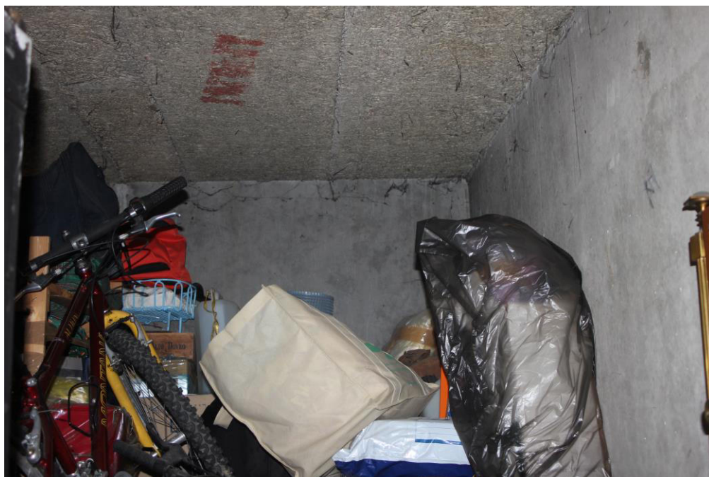
FOTO 12: MILANO, VIA DEI SALICI 6, cantina
