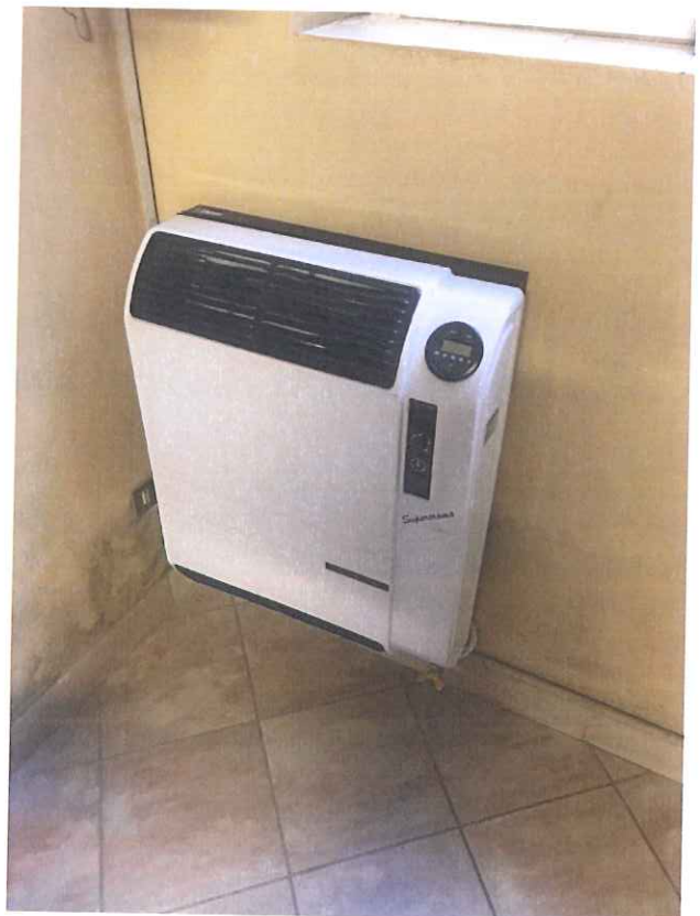
Riscaldamento autonomo a gas
