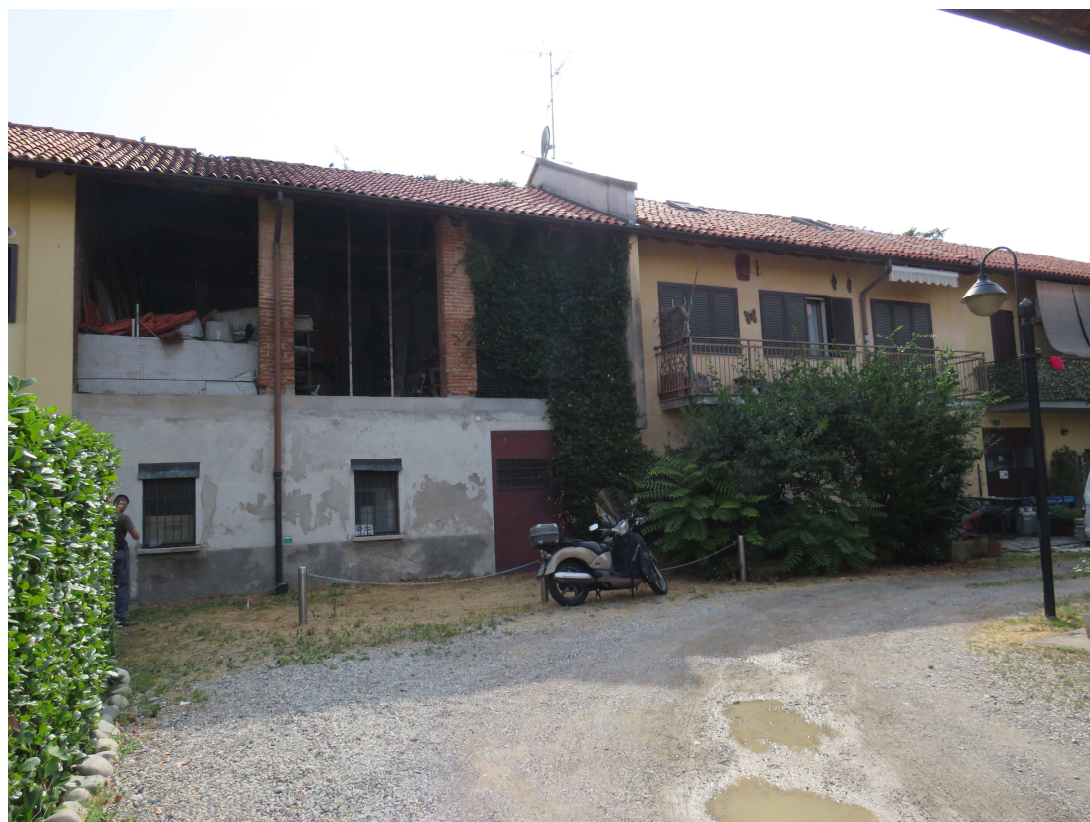
FACCIATA SU CORTILE INTERNO
