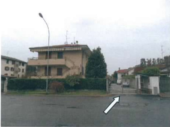
Ingresso carraio e pedonale
