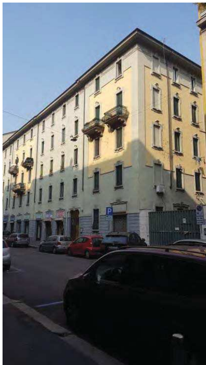
VIA G.A. PLANA, 30- FACCIATA
