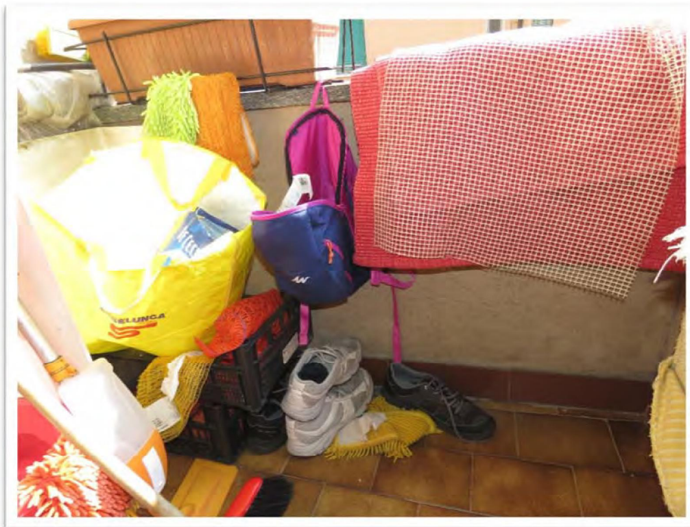
Il balconcino del soggiorno e la caldaia.
