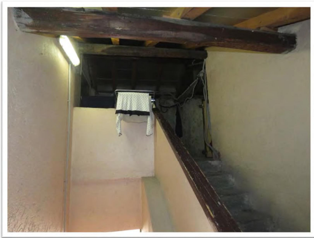
Percorso che conduce al solaio.
