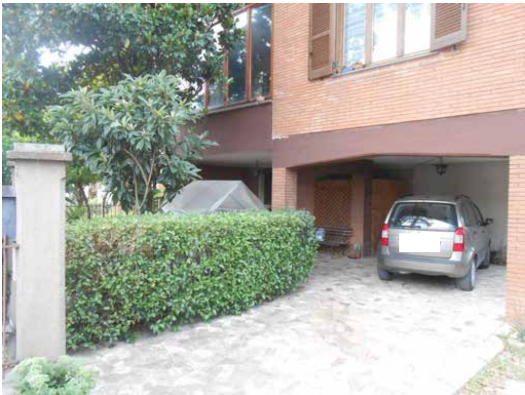
Foto n. 05: area piano terra di non pertinenza
