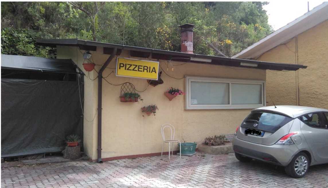
FABBRICATO DA DEMOLIRE SU CORPO B (identificati su planimetria catastale con B1 e B2)
