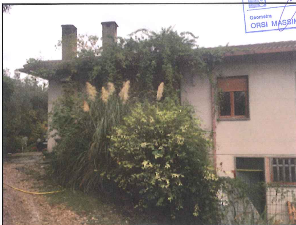
Figura 9: particolare della corte esterna
