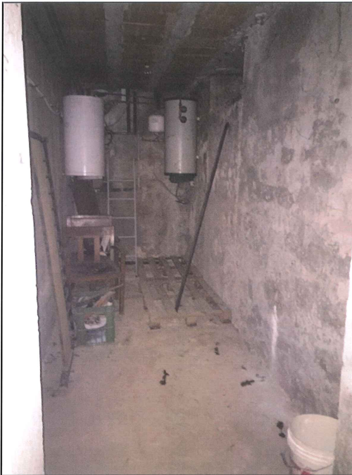
Figura 49: ripostiglio piano S1
