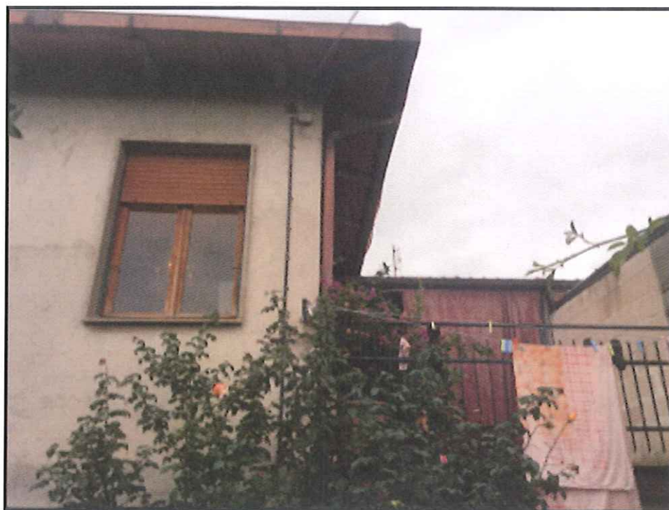
Figura 7: Particolare lato SUD del fabbricato
