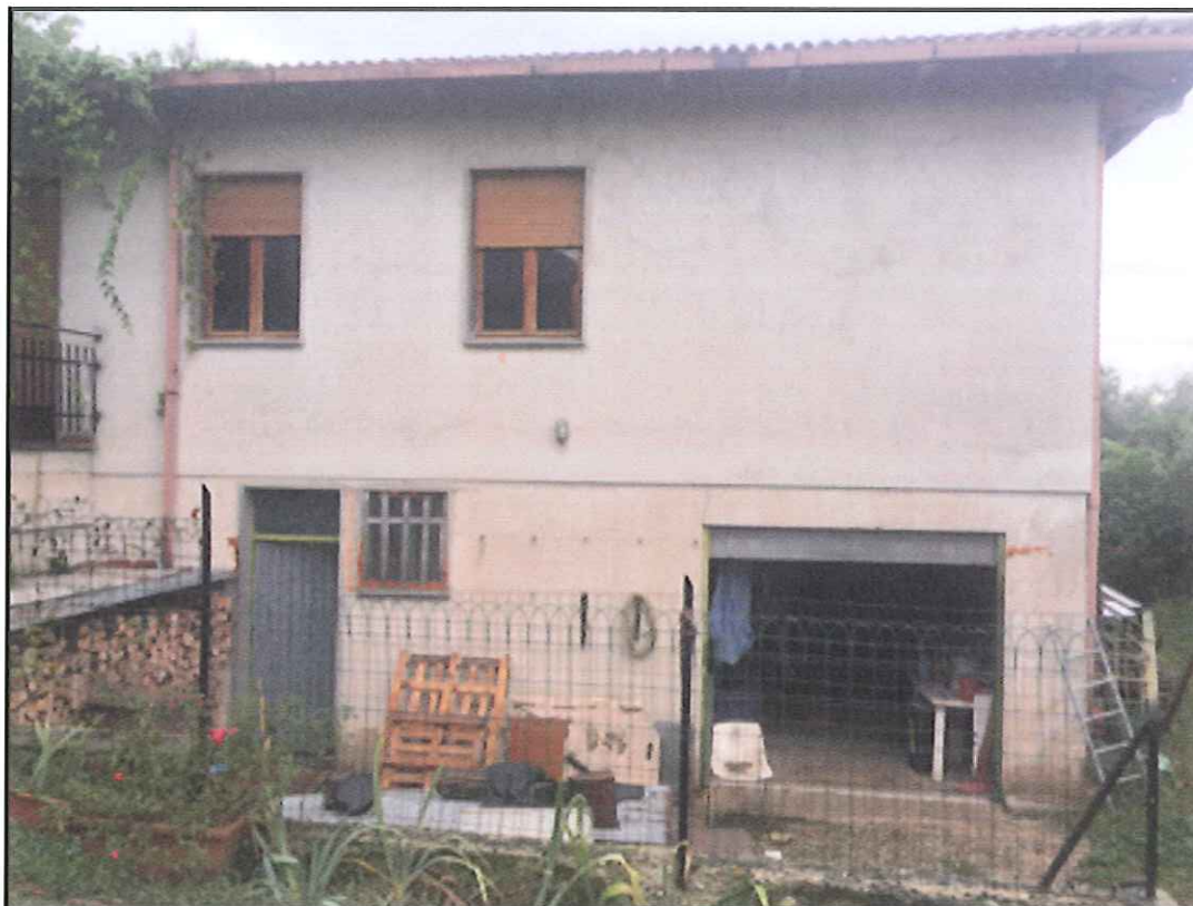
Figura 4: particolare lato OVEST del fabbricato
