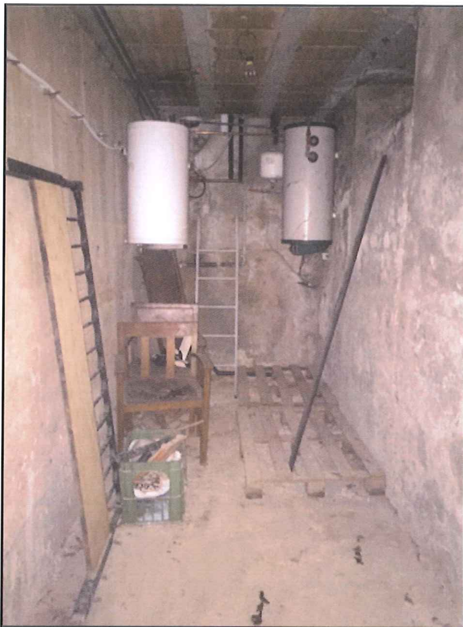
Figura 50: ripostiglio piano S1
