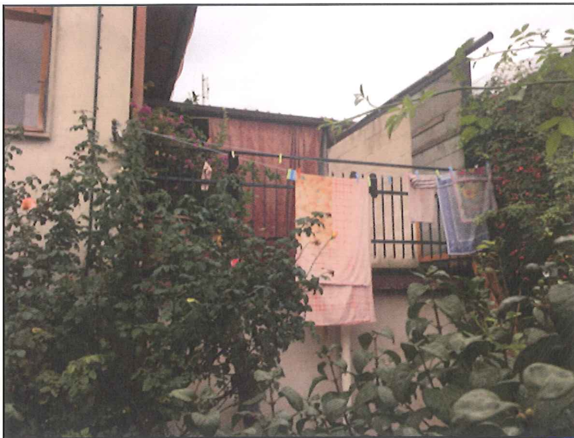
Figura 8: particolare lato SUD del fabbricato
