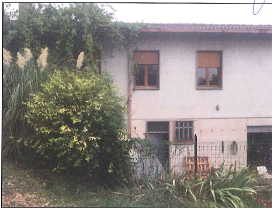
Figura 3 : Particolare lato Ovest del fabbricato.
