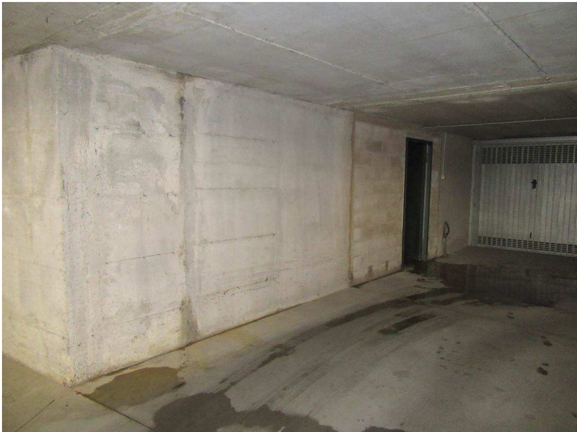
esterno magazzino sub. 45
