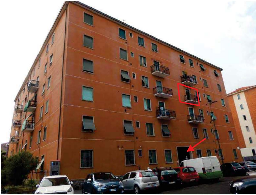
FOTO 1: Vista, dalla Via Cascina Barocco, del fabbricato in cui è sita l'unità pignorata. La freccia indica l'ingresso al condominio, il poligono rosso l'affaccio su strada dell'appartamento in esame.
