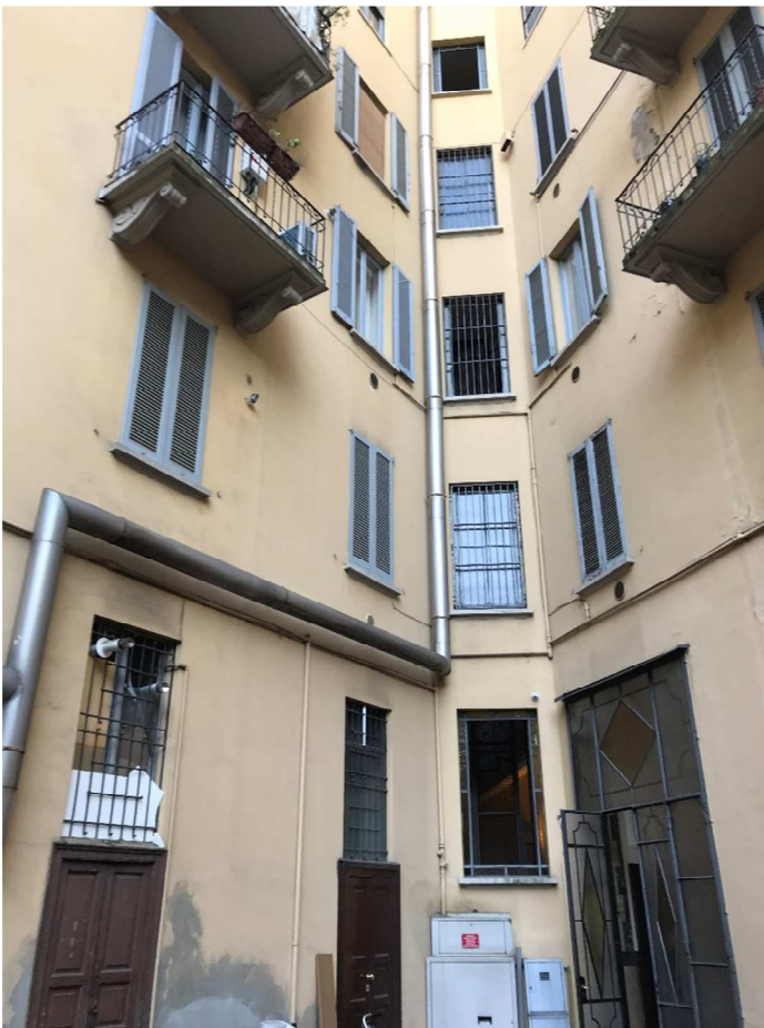
Facciata su cortile
