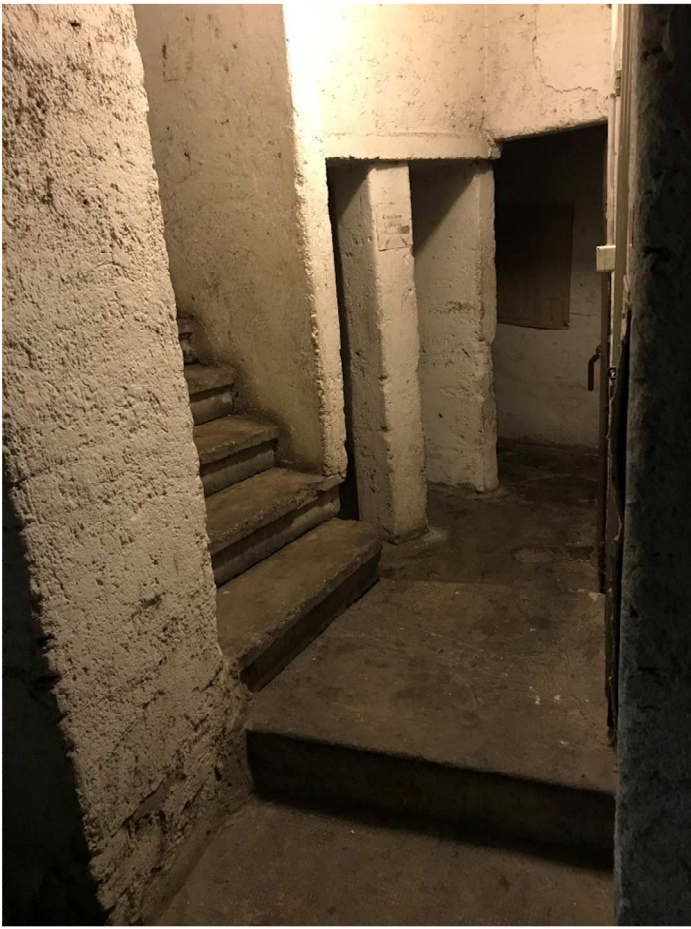
Scala di discesa alla cantina
