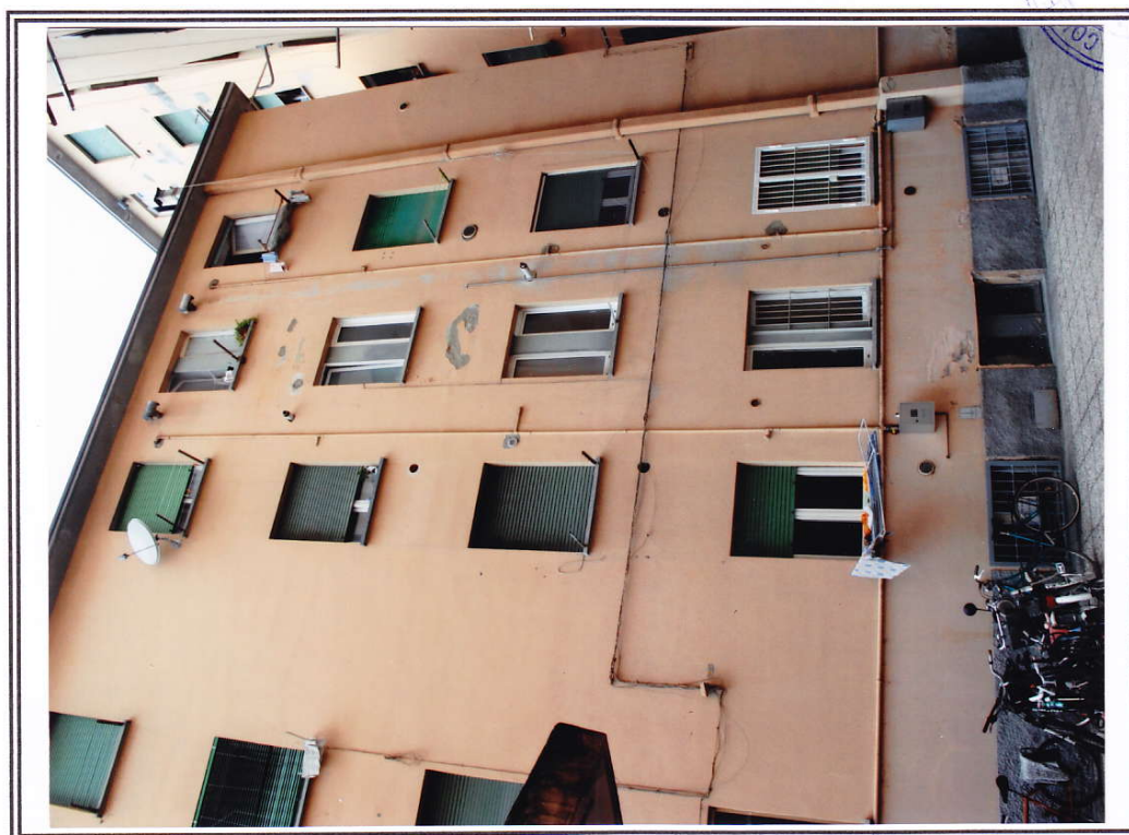
Esterno fabbricato via Farsaglia n. 14
