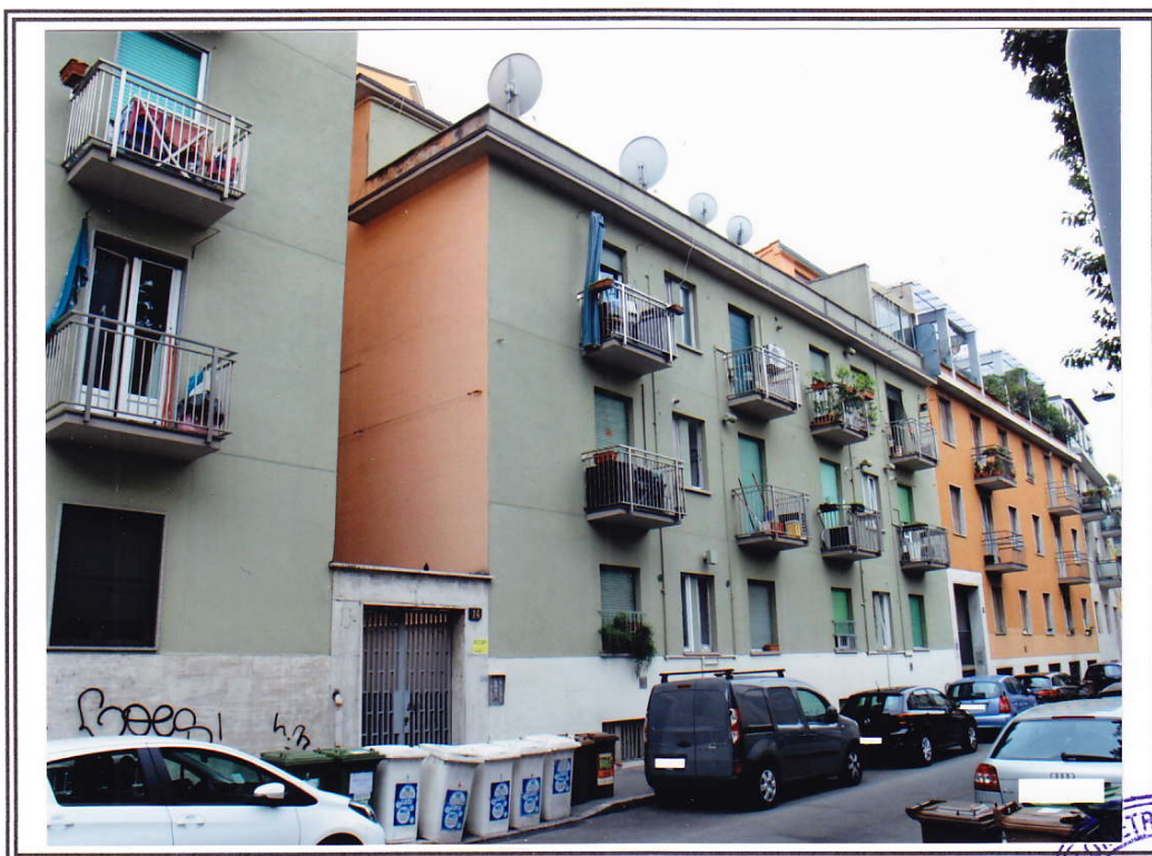
Esterno fabbricato via Farsaglia n. 14
