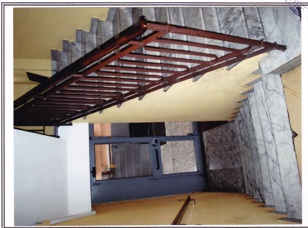
Interno fabbricato via Farsaglia n. 14 – vano scala comune piano T
