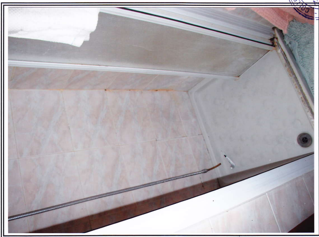
Interno appartamento – bagno
