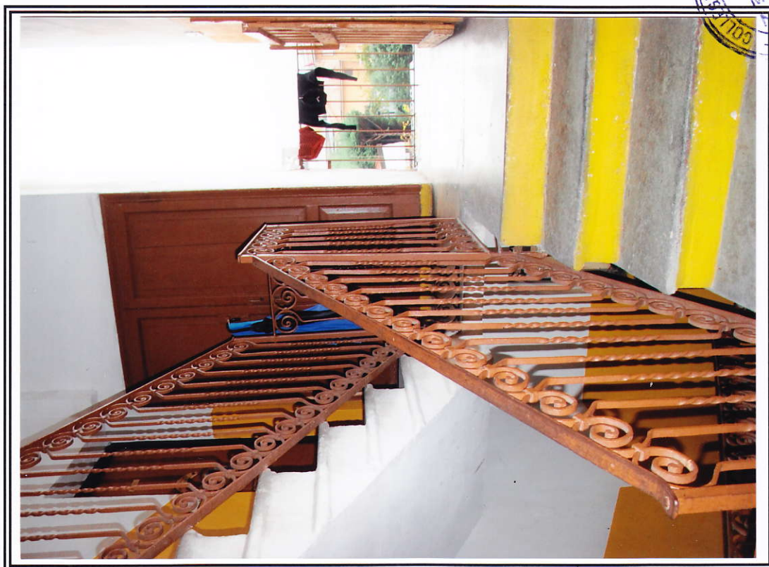
Interno fabbricato – vano scala comune piano 1
