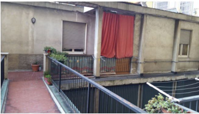
Immobile in via Teano 14 (MI) - corpo di fabbrica interno ove è sito l'appartamento pignorato
