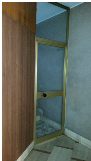
Immobile in via Teano 14 (MI) - scala A porta interna al vano scala
