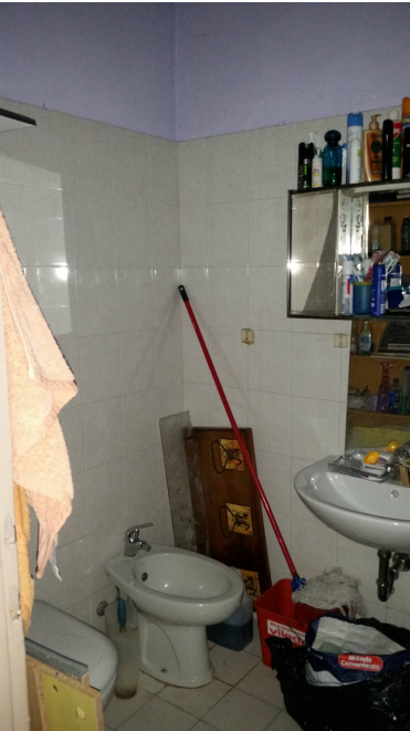
Immobile in via Teano 14 (MI) - u.i. pignorata: servizio igienico
