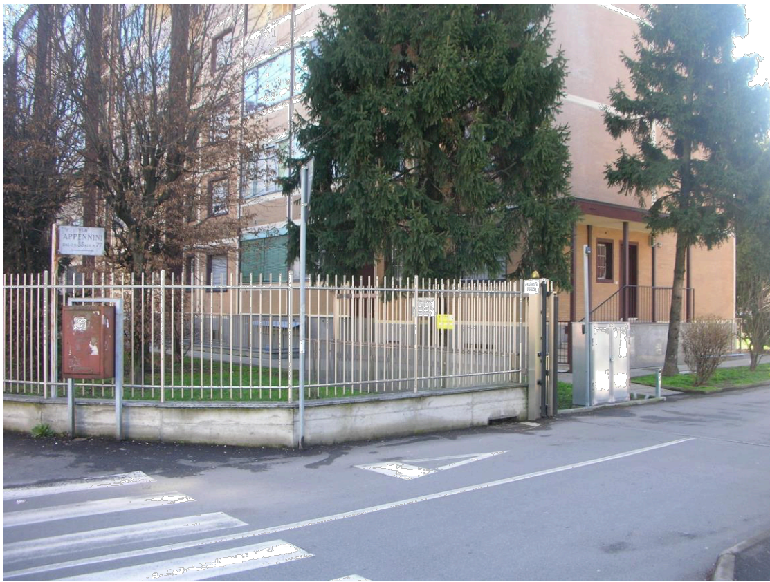
Ingresso via Appennini
