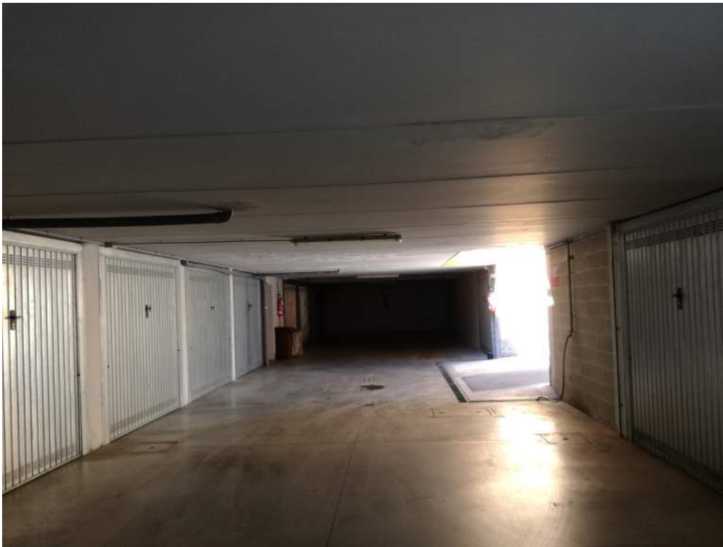
Foto 8 - 10CORSELLO BOX – SCALE COMUNI – CORRIDOIO CANTINE
