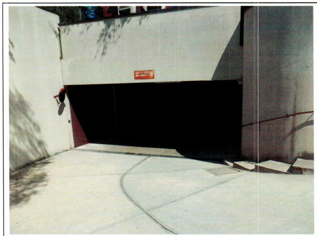
Fotografia n°16 – Vista della rampa d'accesso al piano interrato destinato a box auto
