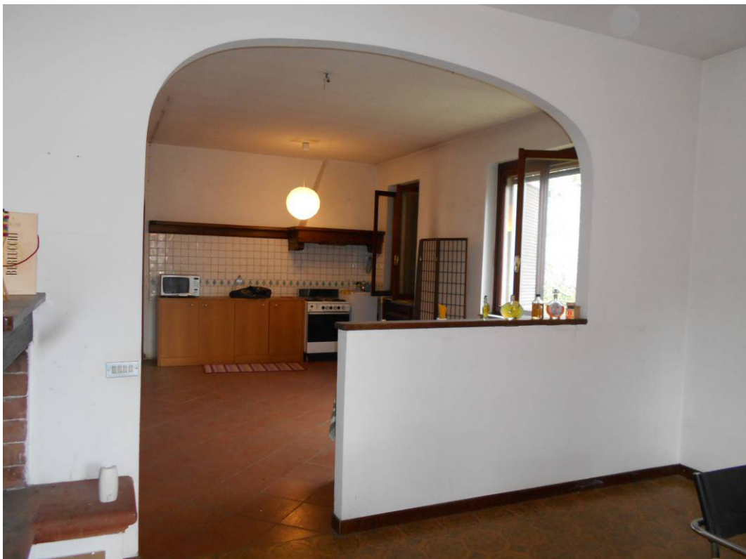
FOTO 9 – La cucina con in evidenza la parziale demolizione del tavolato
