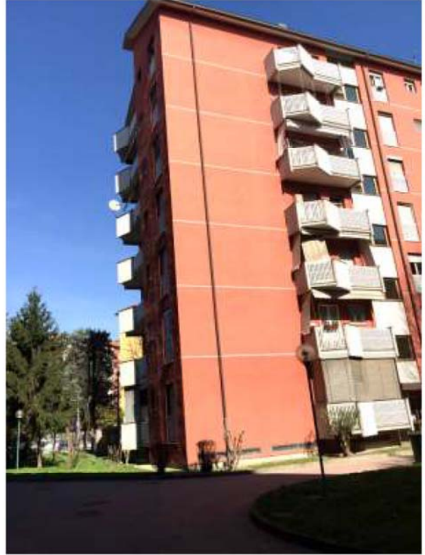
Vista fabbricato dal retro
