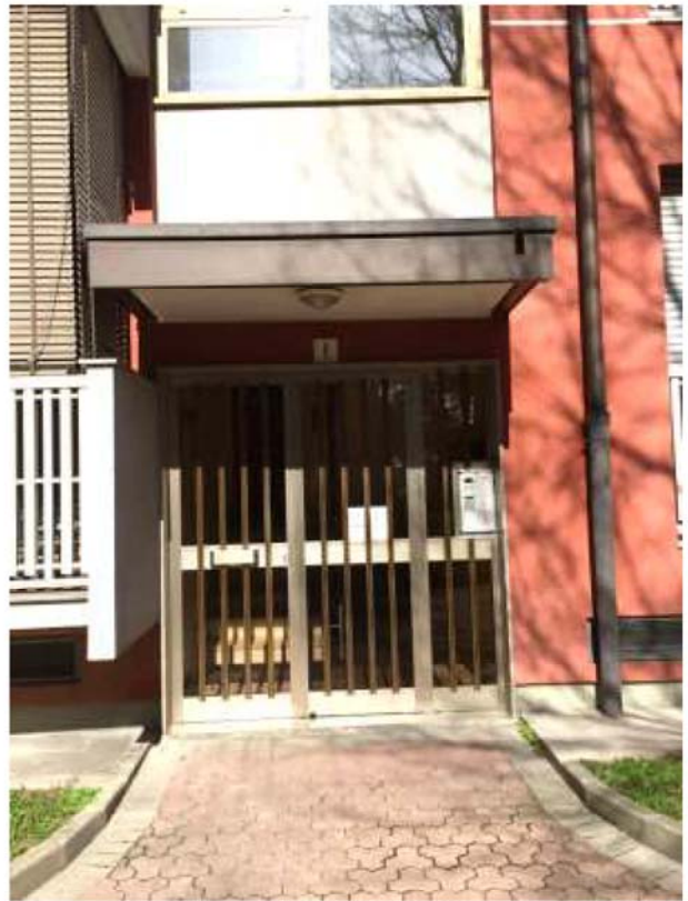
Vista portone ingresso scala I
