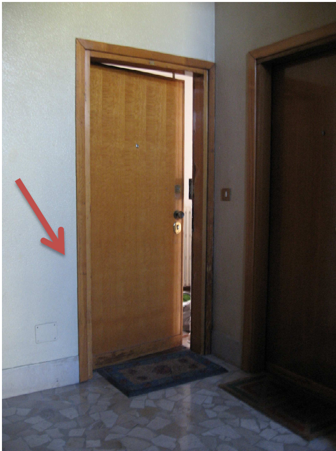
Foto 4 – Ingresso appartamento secondo piano
