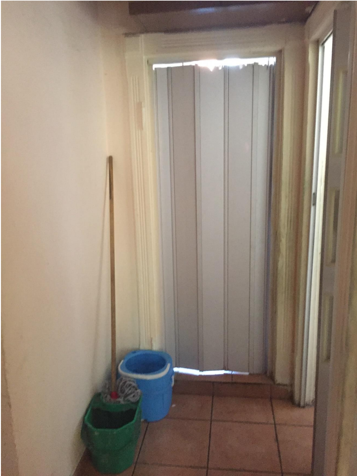
Ingresso Camera 1 + porta bagno
