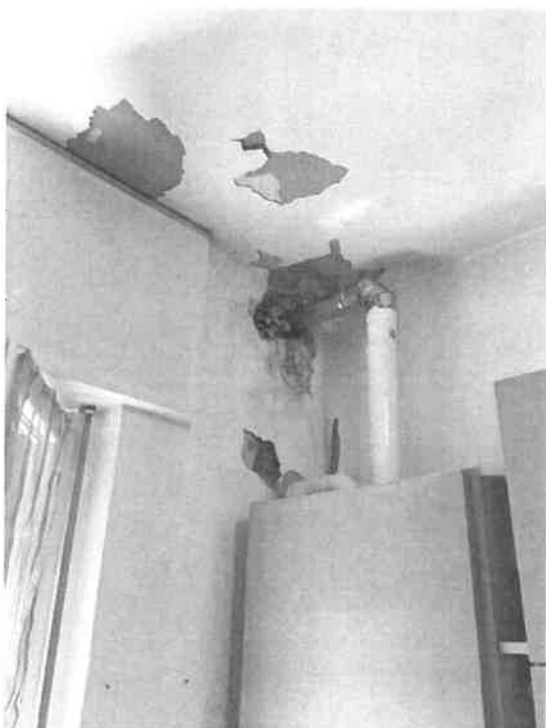
Pioltello (MI), Via Roma n. 97 – Dettaglio degli episodi di infiltrazioni d'acqua ed umidità rilevati in cucina (immagine a sinistra) e camera verso cortile (a destra).
