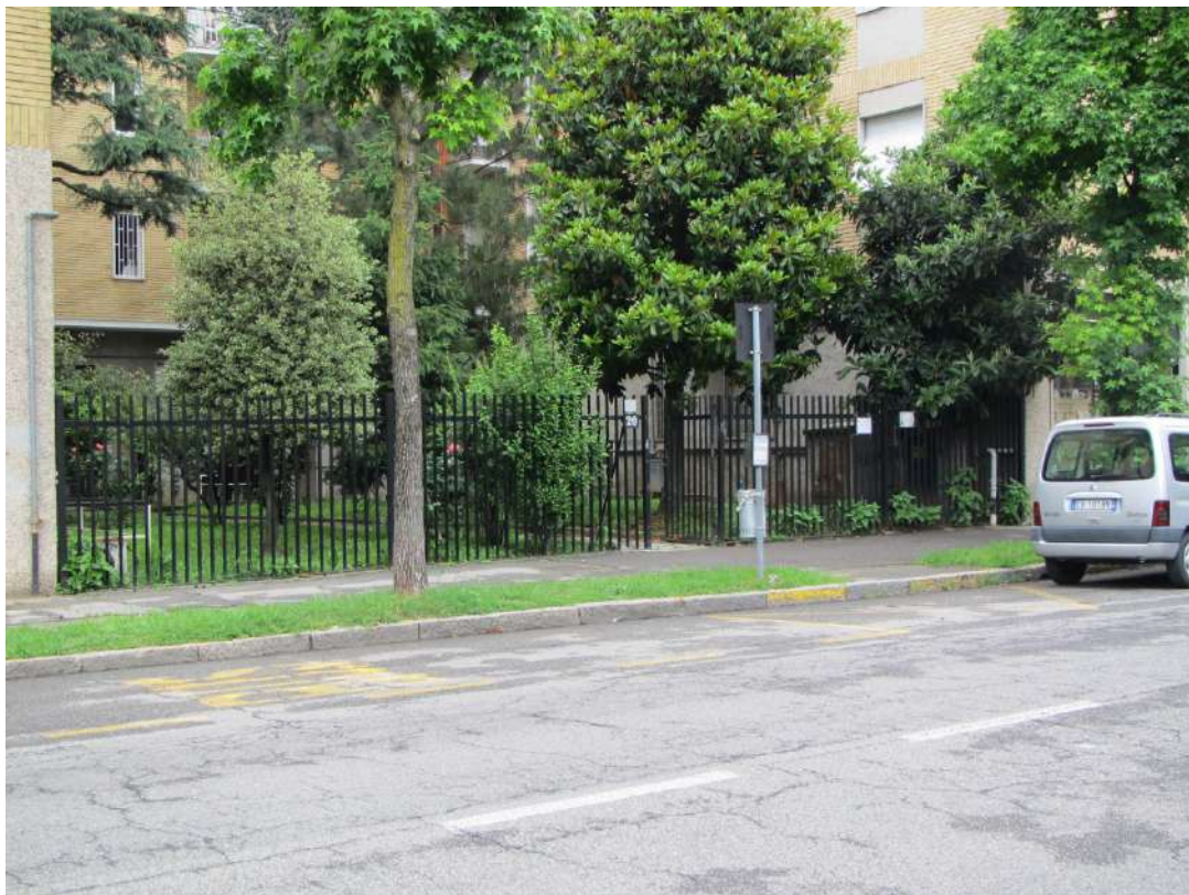
Recinzione e cancello pedonale del complesso edilizio
