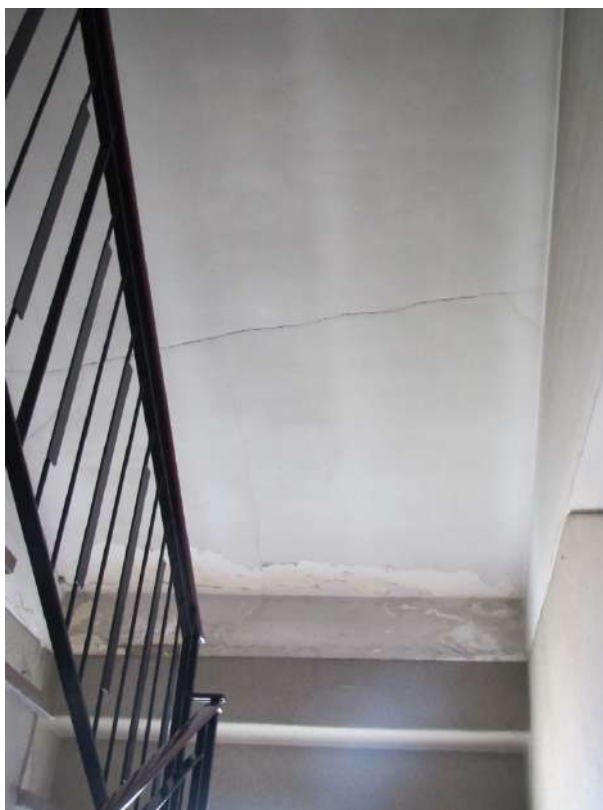
Dettaglio – Plafone del vano-scala
