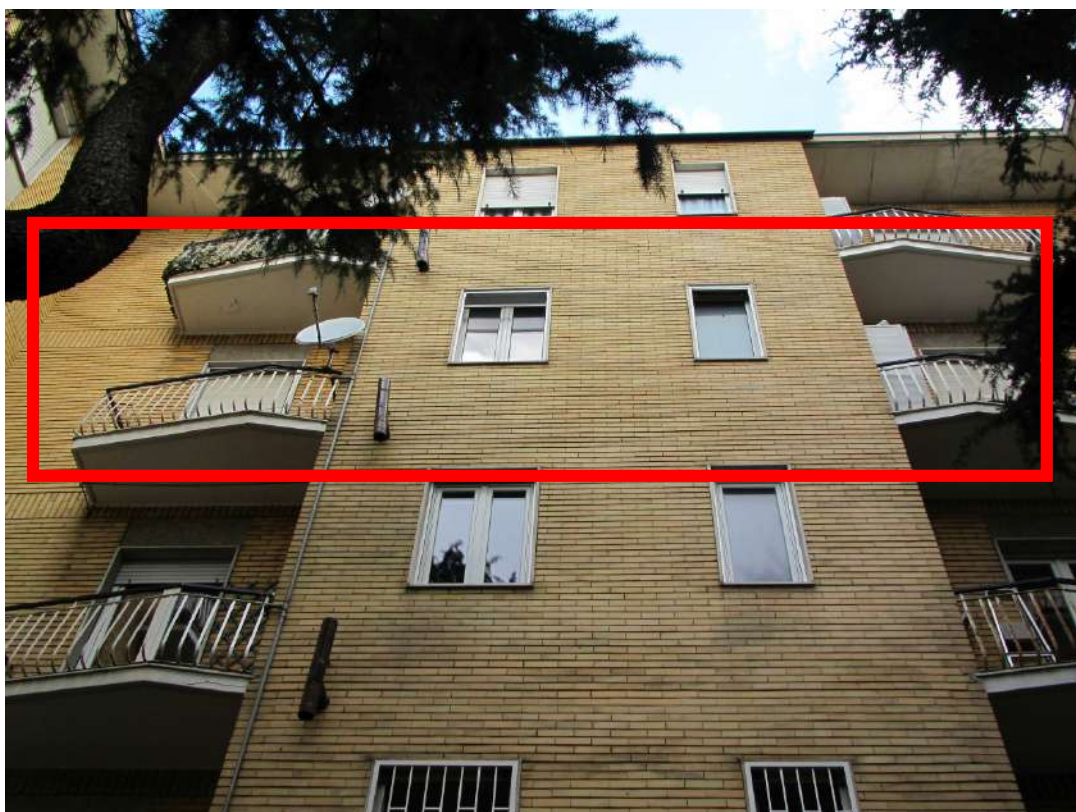
Fronte dell'edificio n. 20/A
