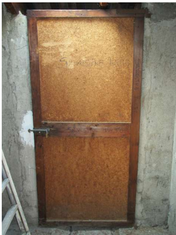
Porta del solaio pertinenziale
