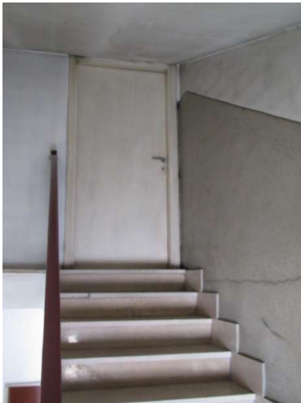
Porta di ingresso al sottotetto dell'edificio n. 20/A
