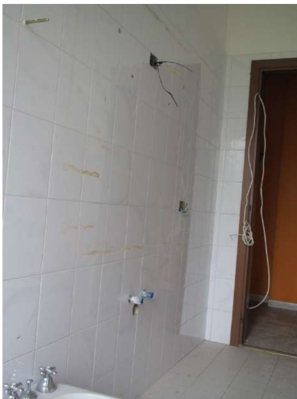
Zona del bagno ove era ubicato il lavandino
