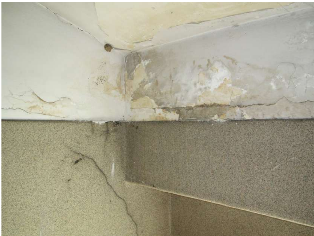
Dettaglio – Plafone del vano-scala
