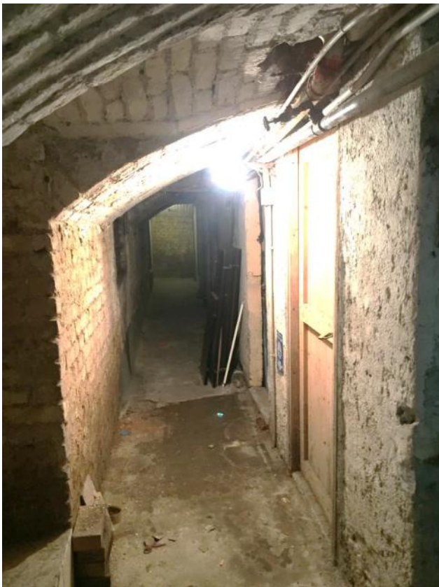
Vista locali cantine
