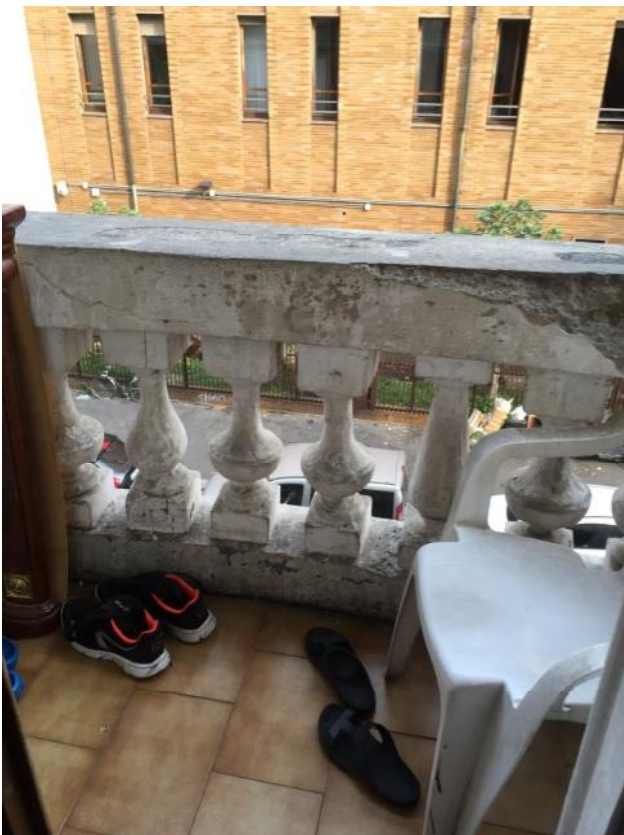
Viste balcone su Via Marco Aurelio
