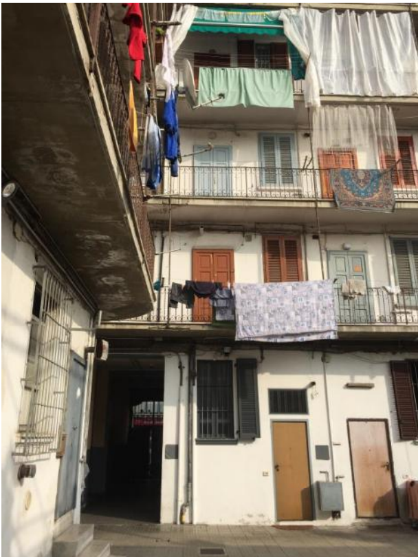
Vista del fabbricato dal cortile comune
