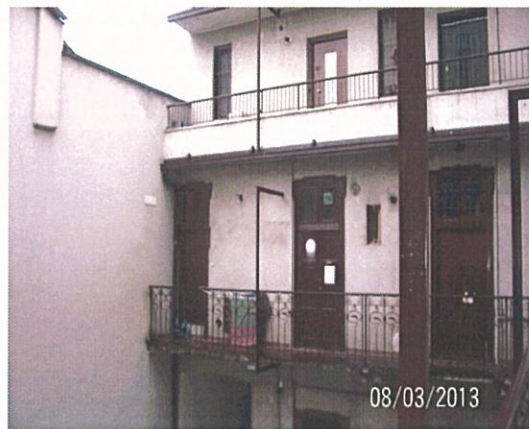
VEDUTA DAL CORTILE
