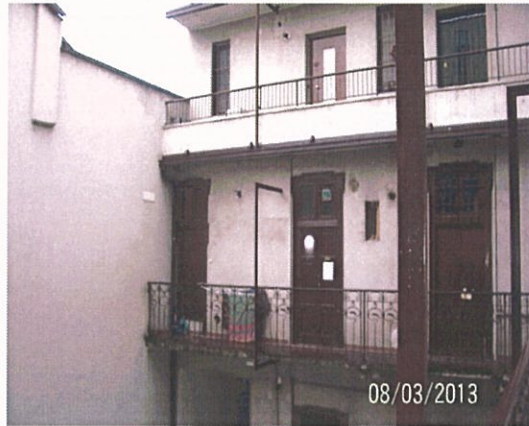
VEDUTA DAL CORTILE
