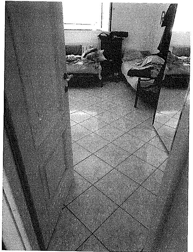
Accesso al locale notte munito di porta lignea; pavimentazioni in monocottura di recente sostituzione ed infisso in alluminio con doppi vetri.
