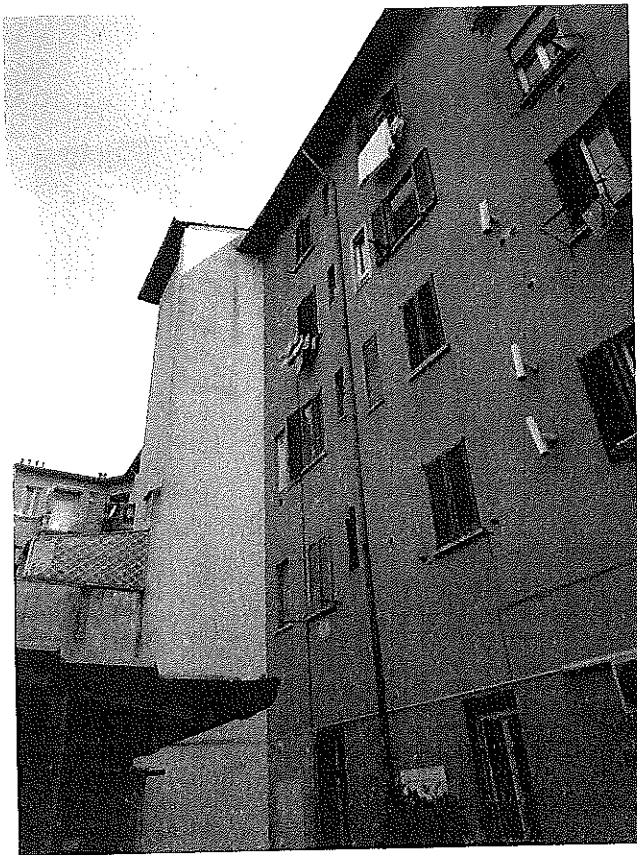
Facciata interna rilevata con stesura d'intonaco spatolato e corte interna rilevata con pavimentazione in battuto di cemento; presenza d'impianto di videosorveglianza da verificare se operativo.
