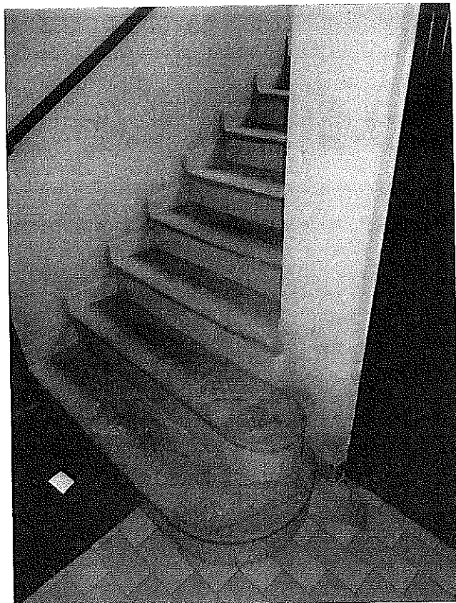
Particolari dell'atrio portineria rilevato con pavimentazioni in monocottura e scala a due rampe realizzata con gradini in pietra naturale.
