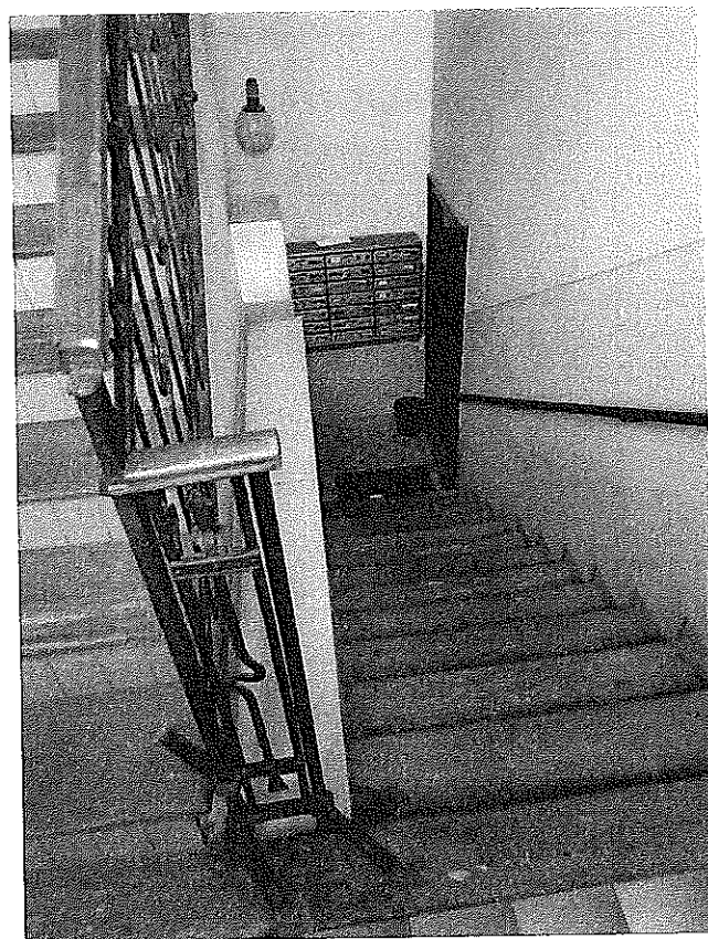
Locale contatori rilevato internamente; vano scala realizzato con balastra in ferro battuto e corrimano ligneo.
