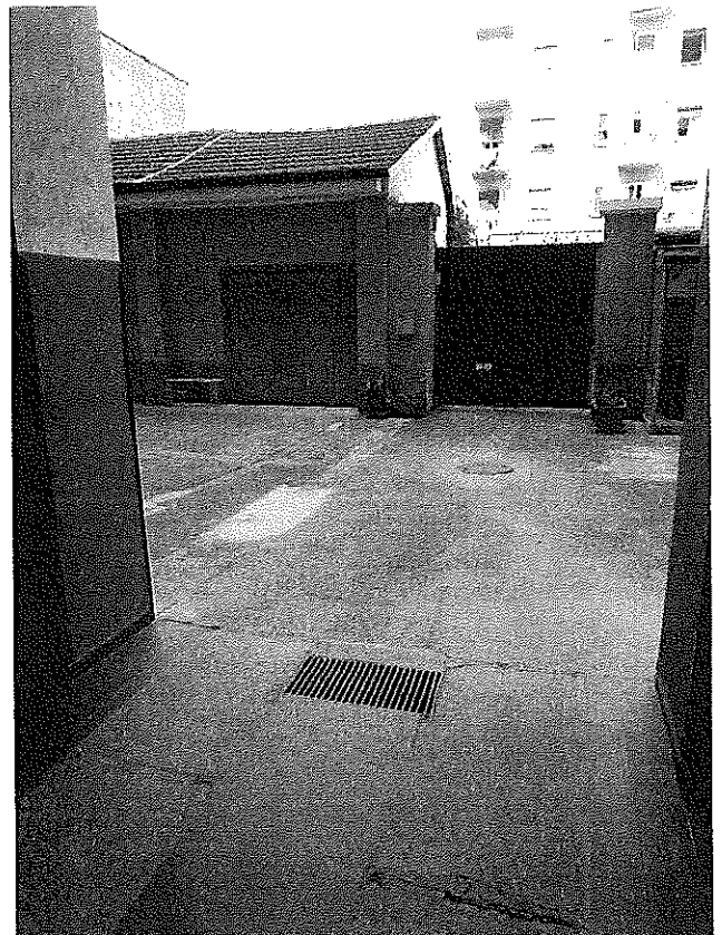
Particolari dell' accesso all' atrio portineria e alla corte interna; pavimentazioni in batturo di cemento e gres, soglie e davanzali in pietra naturale e serizzo.
