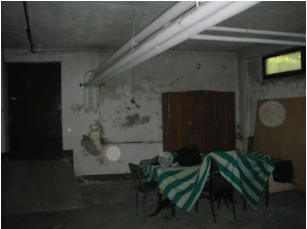
Locale unico ricavato demolendo le cantine, tra cui quella assegnata al momento del rogito
