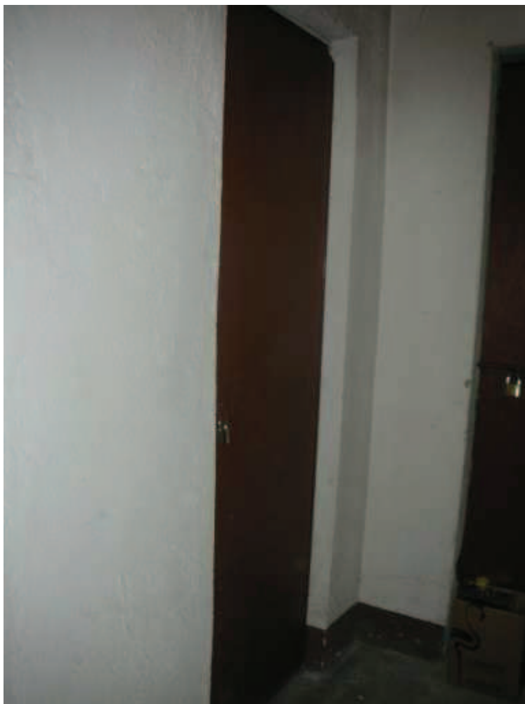
Cantina ad uso dell'appartamento
