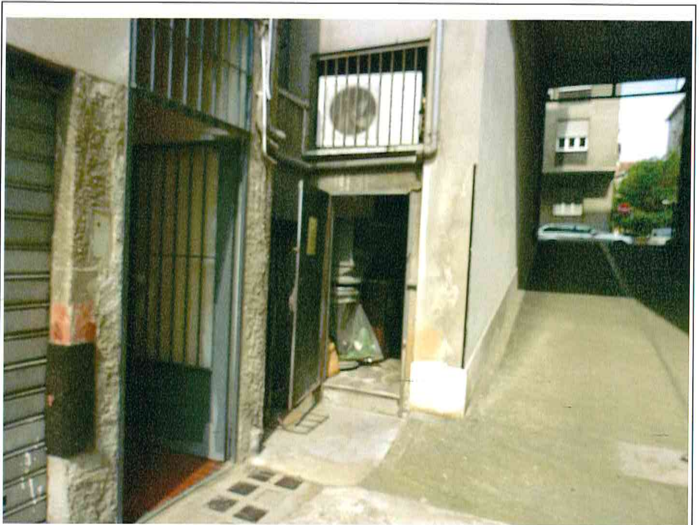
Ingresso su passo carrabile (vista esterna)
