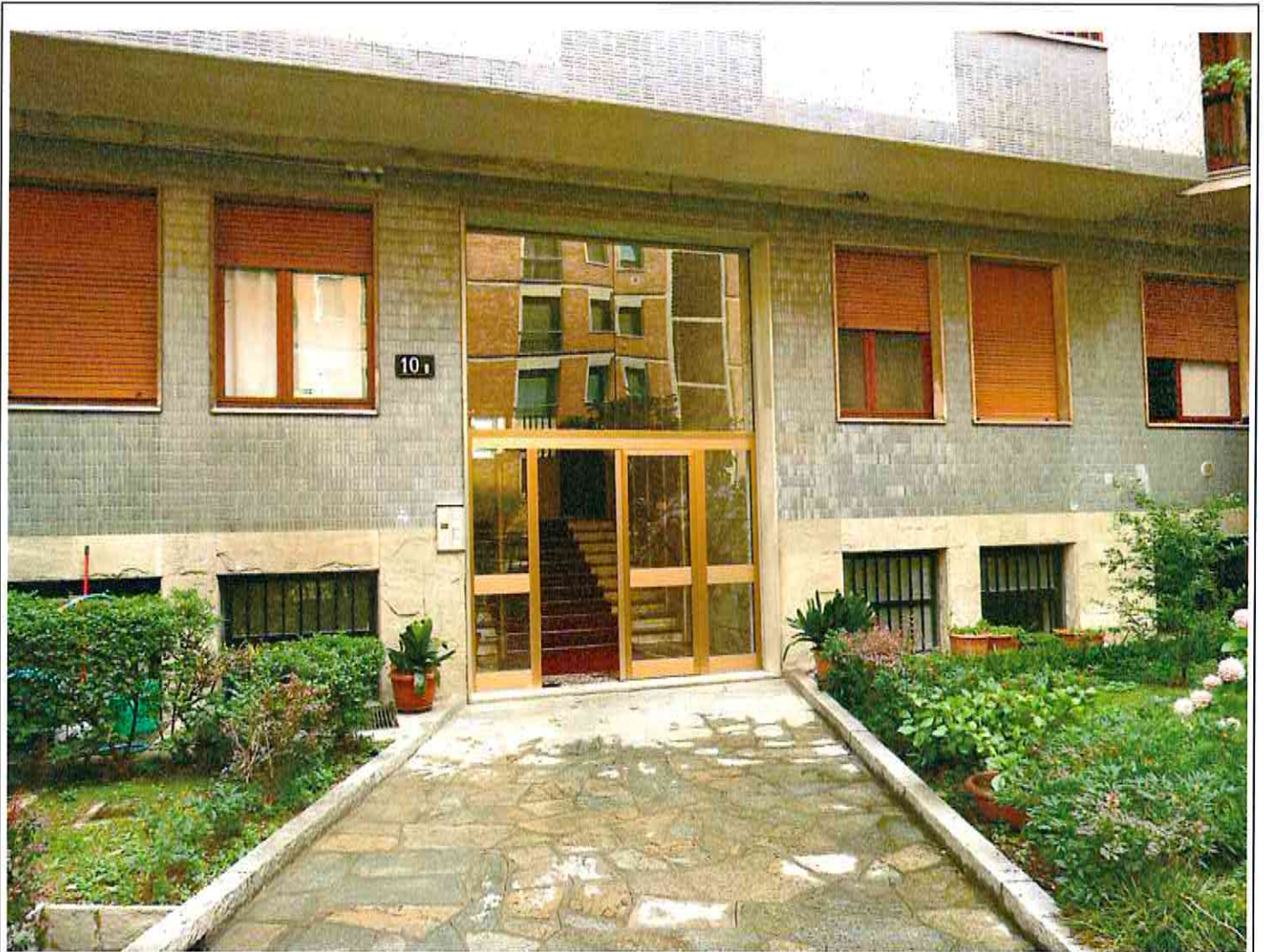
Ingresso condominio (via Pomezia 10/B)
