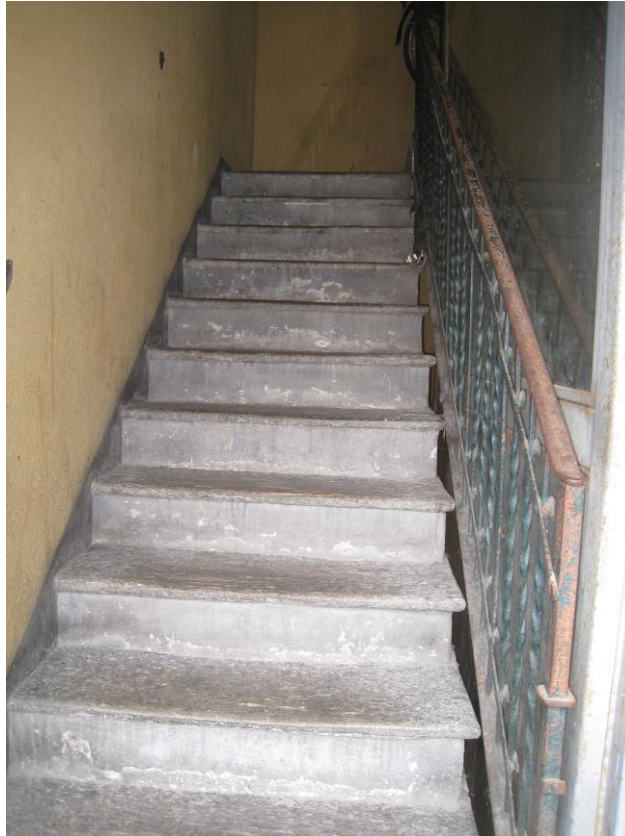
Vano scala comune
