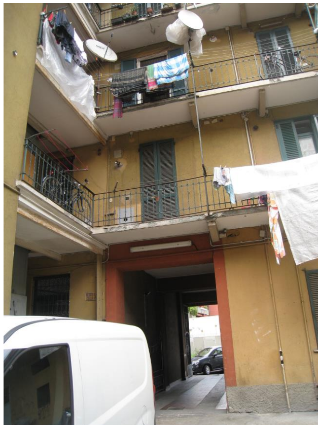
Facciata verso cortile
