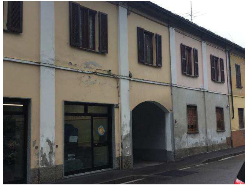
Foto n.1 – Prospetto su via Tornaghi
