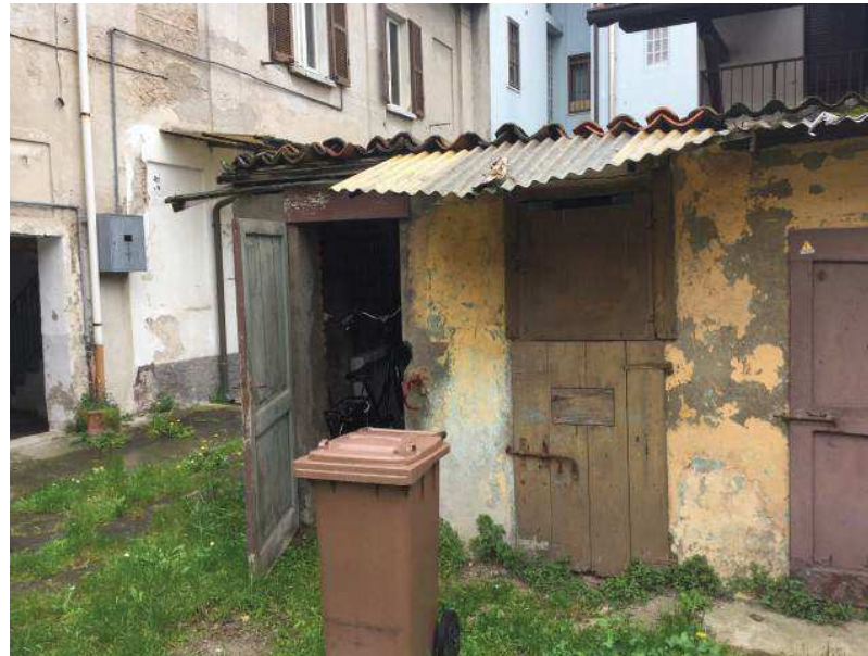
Foto n.11 – Cantina di pertinenza
