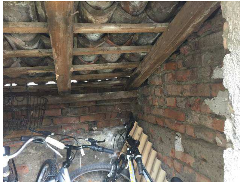
Foto n.12 – Cantina di pertinenza
