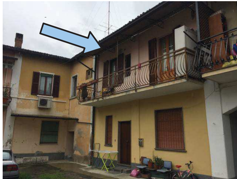
Foto n.2 – Prospetto su cortile interno
